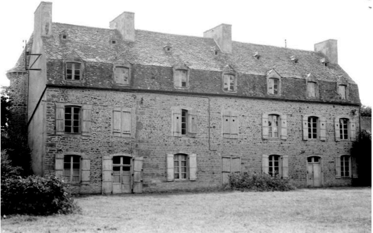
Vue générale du dos du logis du château du Boyer
