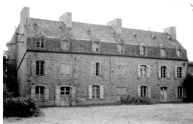
Vue générale du dos du logis du château du Boyer Phot. Laffiché Sylvie, Phot. Catherine Lozach IVR53_19745605174Z
