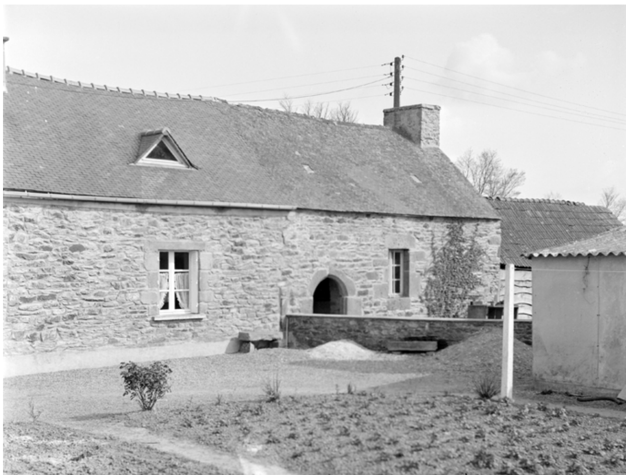
Kereven - Ferme, façade antérieure : vue générale (état en 1974).
