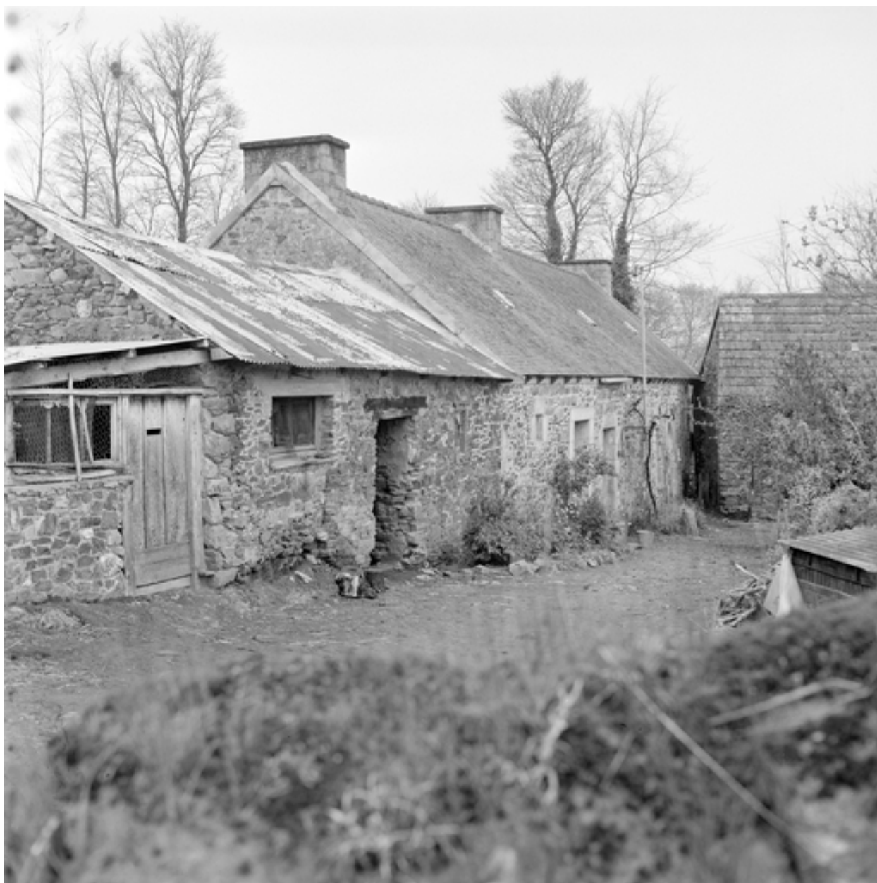
Kervalgon - Ferme - Façade principale : vue générale.
