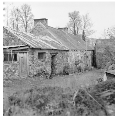
Kervalgon - Ferme - Façade principale : vue générale. Phot. Norbert Lambart IVR53_19902200635X
