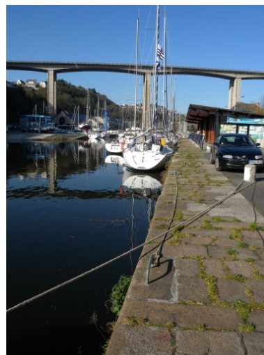
Vue du mur de quai, rive gauche du bassin à flot Phot. Guy Prigent IVR53_20082212996NUCA
