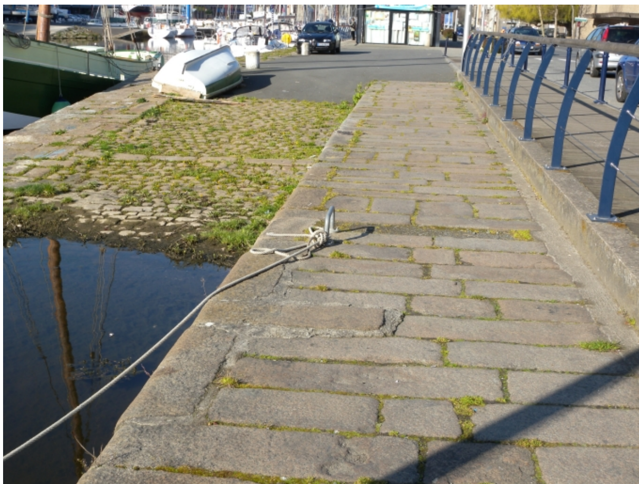
Vue de l'ancien quai d'Aiguillon, aménagé pour la plaisance, avec sa cale double cale
