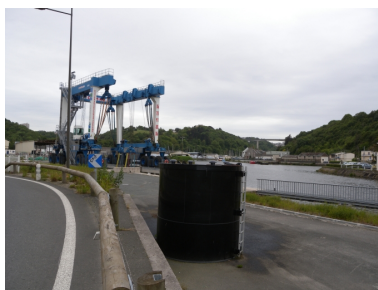
La nouvelle grue de 350 tonnes de charge à côté de l'ancienne voie de chemin de fer, quai Surcouf
