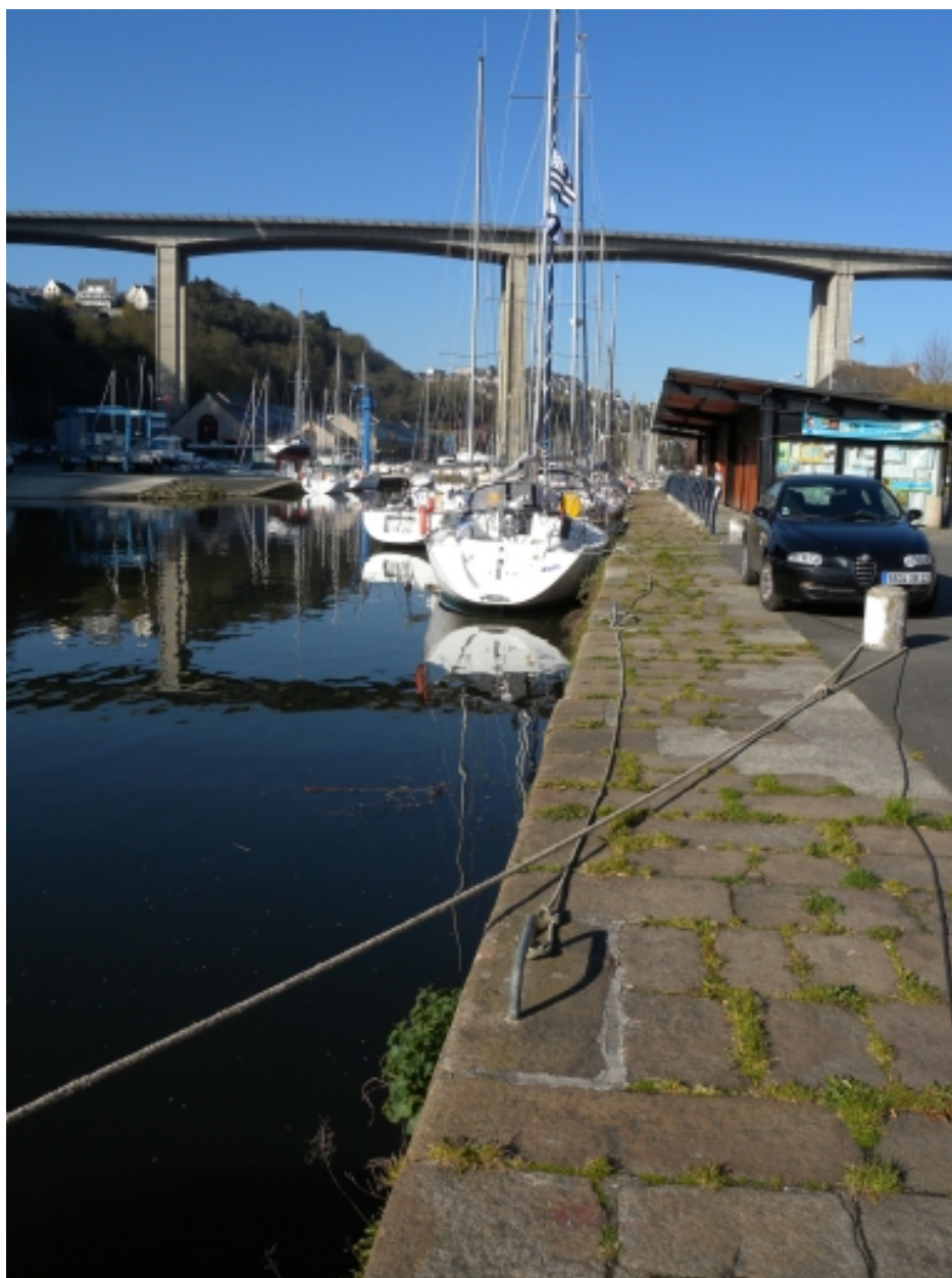
Vue du mur de quai, rive gauche du bassin à flot
