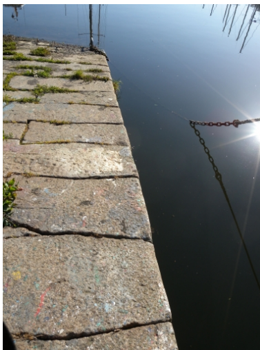
Vue de la disposition des dalles de granite qui recouvrent en parement le quai Phot. Guy Prigent IVR53_20082212997NUCA
