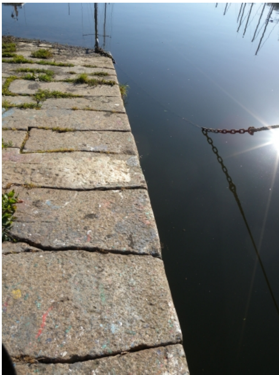
Vue de la disposition des dalles de granite qui recouvrent en parement le quai
