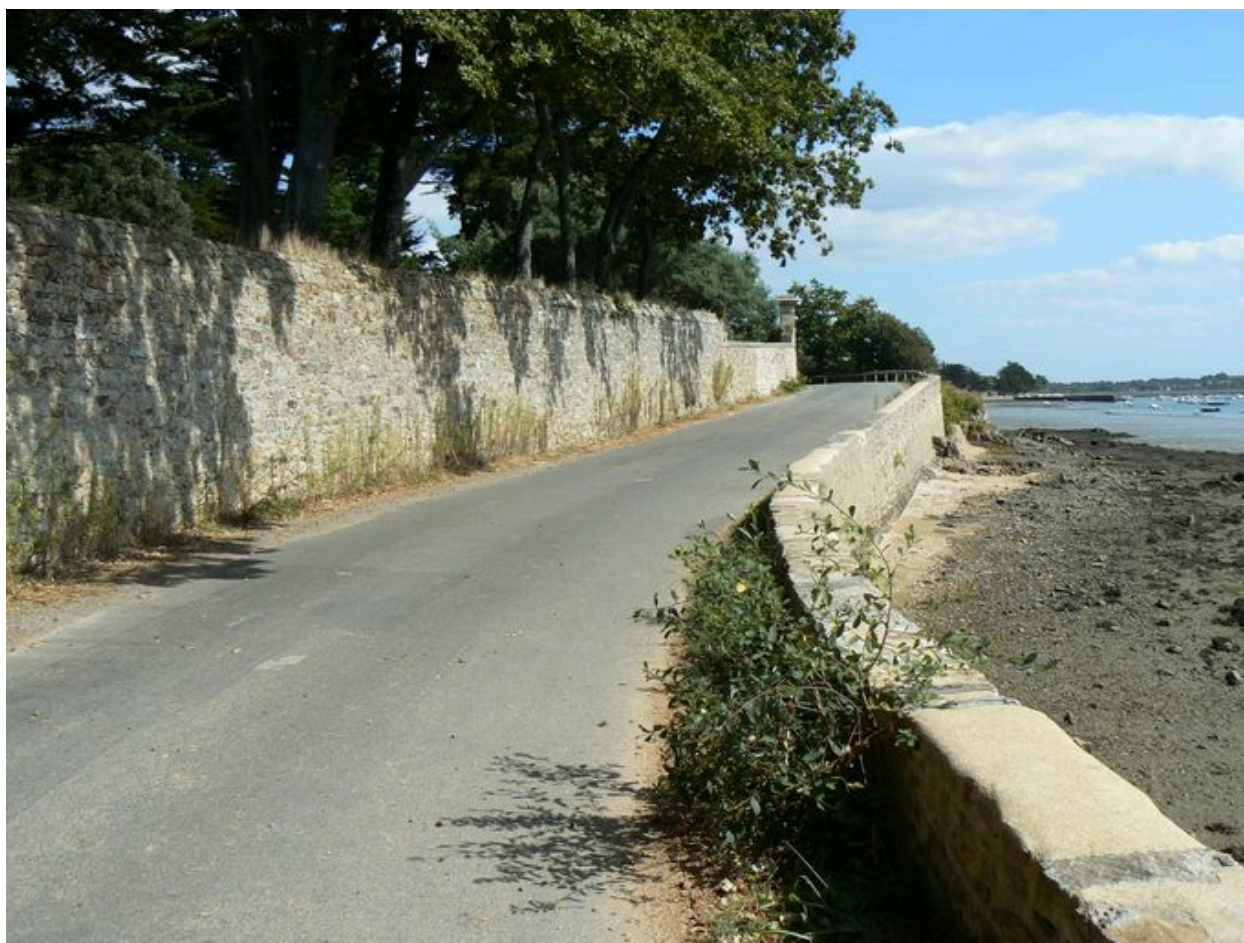
Digue-route du Passage Saint-Armel
