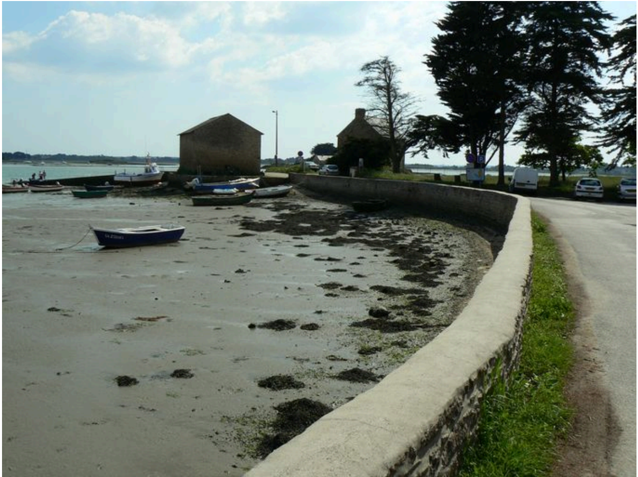
Digue-route du Passage Saint-Armel
