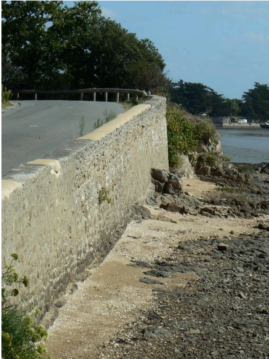
Digue-route du Passage Saint-Armel
