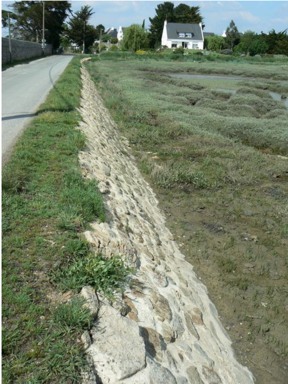
Digue-route du Passage Saint-Armel
