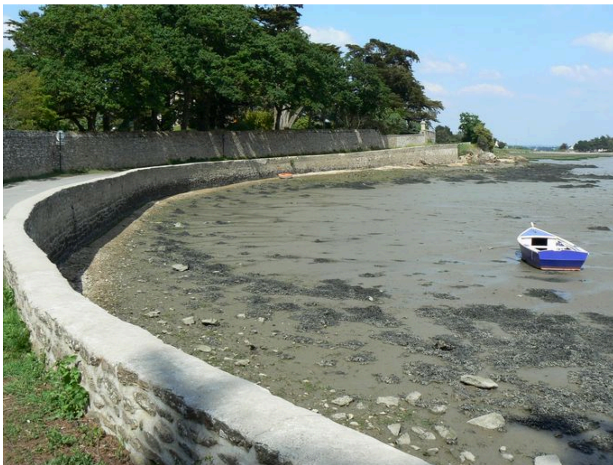
Vue générale de la digue-route du Passage Saint-Armel
