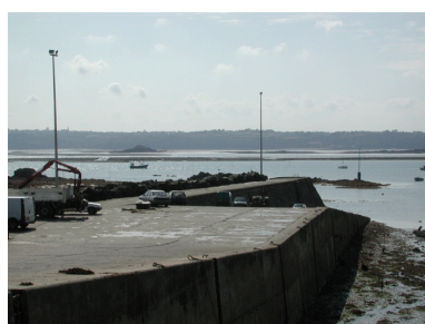
Vue de la cale, du mole et du terre-plein Phot. Guy Prigent IVR53_20082207218NUCA
