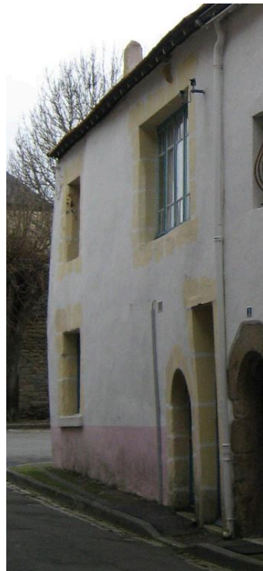
Mur gouttereau, 4 rue de la paix Phot. Pierre Laurent Constantin IVR53_20225605105NUCA
