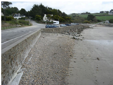
Vue générale de la digue- route de Postolonnec Phot. Guillaume Marie IVR53_20082908329NUCA
