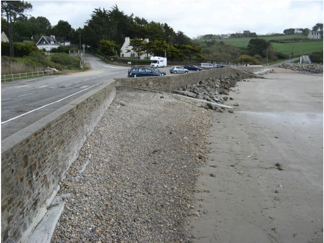
Vue générale de la digue-route de Postolonnec
