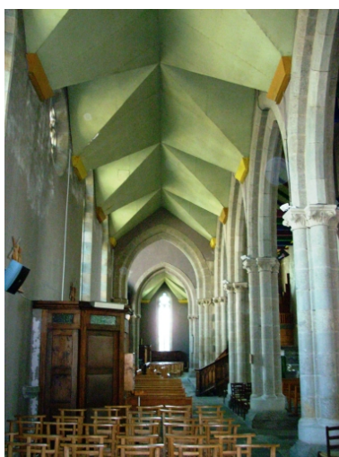
Plougastel-Daoulas, église Saint- Pierre : transept sud depuis l'est Phot. Gwénaél Fauchille IVR53_20082906069NUCA
