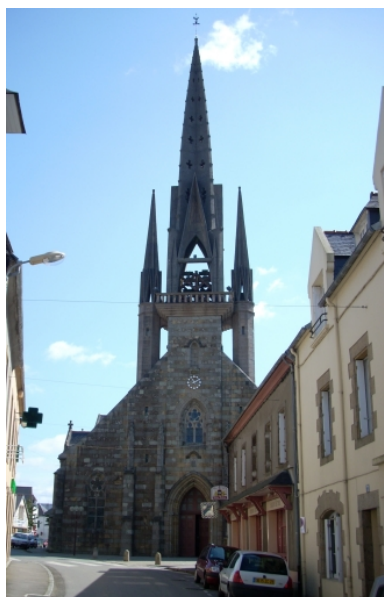
Plougastel-Daoulas, église Saint-Pierre : élévation ouest Phot. Gwénaél Fauchille IVR53_20082906065NUCA
