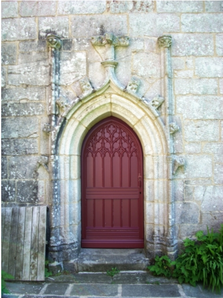
Clohars-Fouesnant, chapelle du Drennec : détail, porte ouest de la chapelle sud
