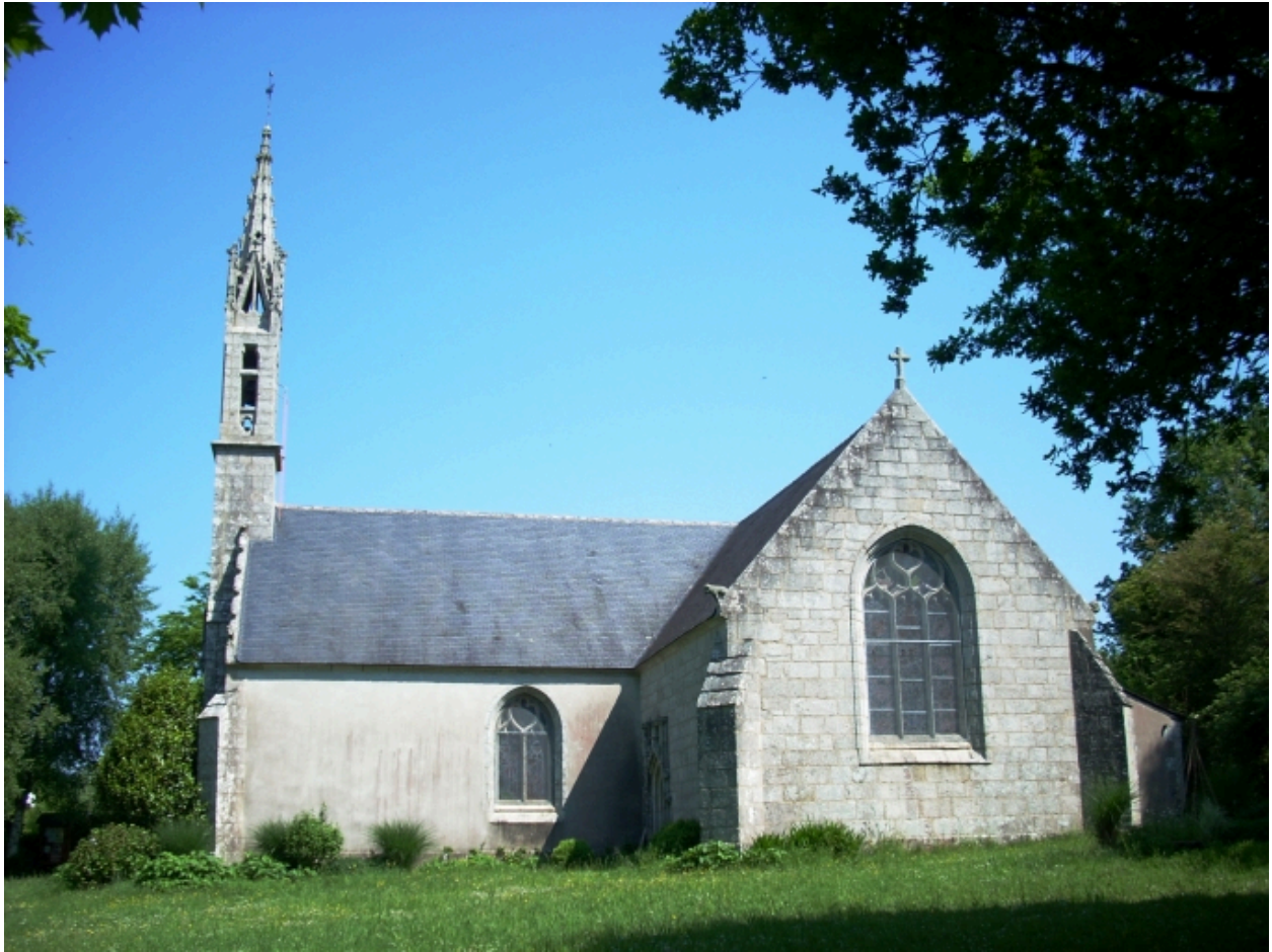
Clohars-Fouesnant, chapelle du Drennec : vue générale sud
