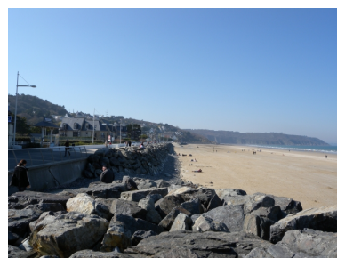
Vue des enrochements devant la digue-promenade Phot. Guy Prigent IVR53_20082213270NUCA
