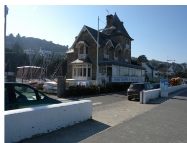
Vue des bâtiments du centre municipal de voile Repro. Guy Prigent IVR53_20082213276NUCB
