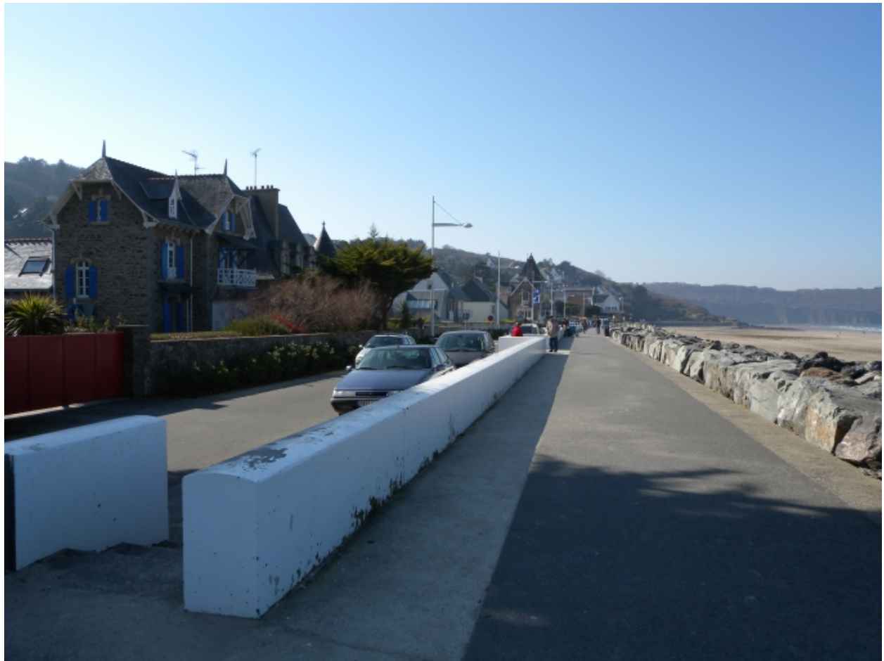
Vue de la digue-promenade en béton avec son corps principal, sur une longueur de 1000 mètres environ
