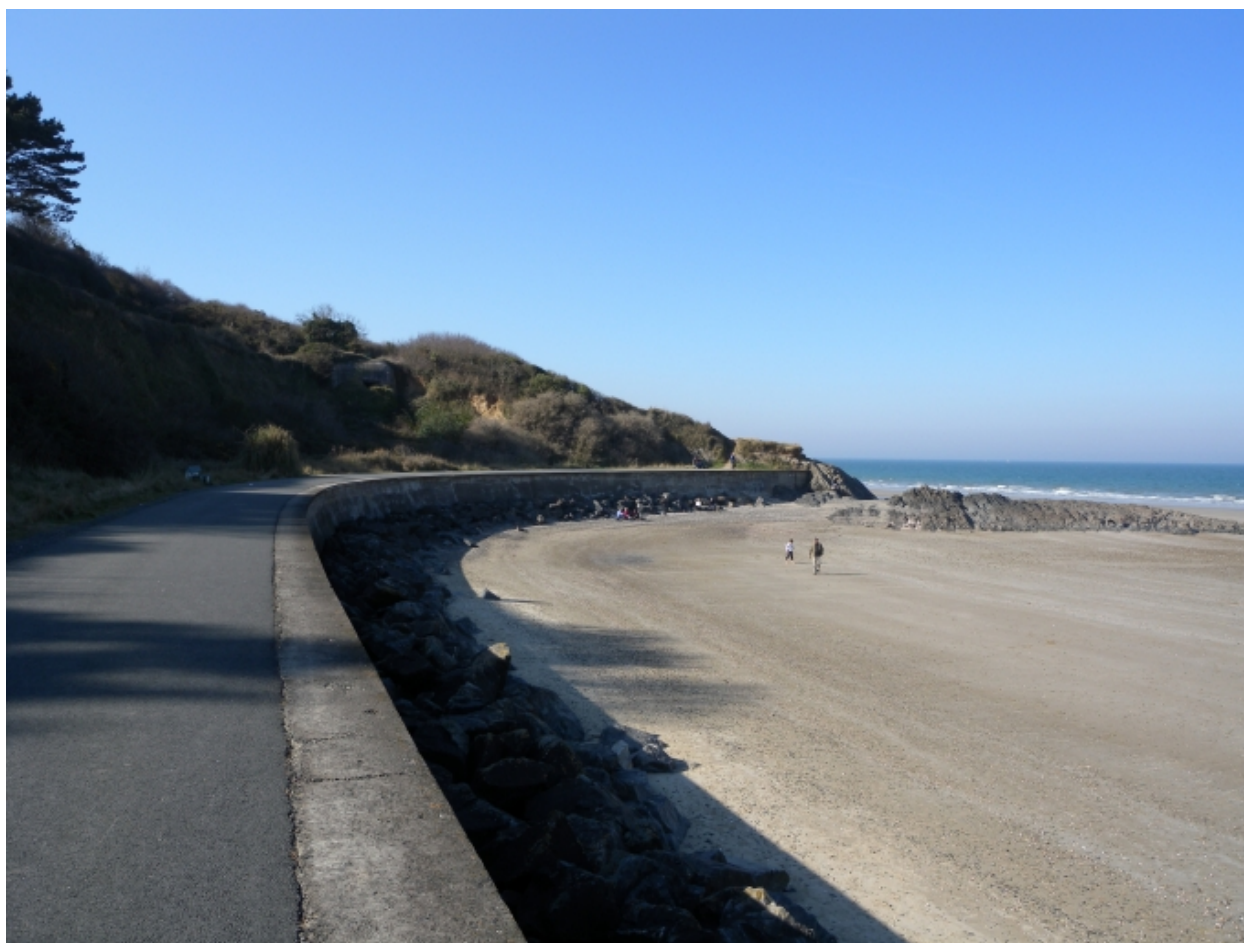
Vue du prolongement de la digue-promenade en direction de Tournemine
