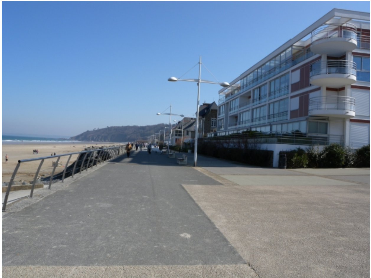
Vue des immeubles modernes sur la digue-promenade
