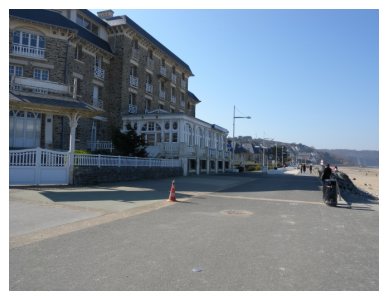
Vue des immeubles anciens (début 20ème siècle) sur la digue-promenade Phot. Guy Prigent IVR53_20082213269NUCA
