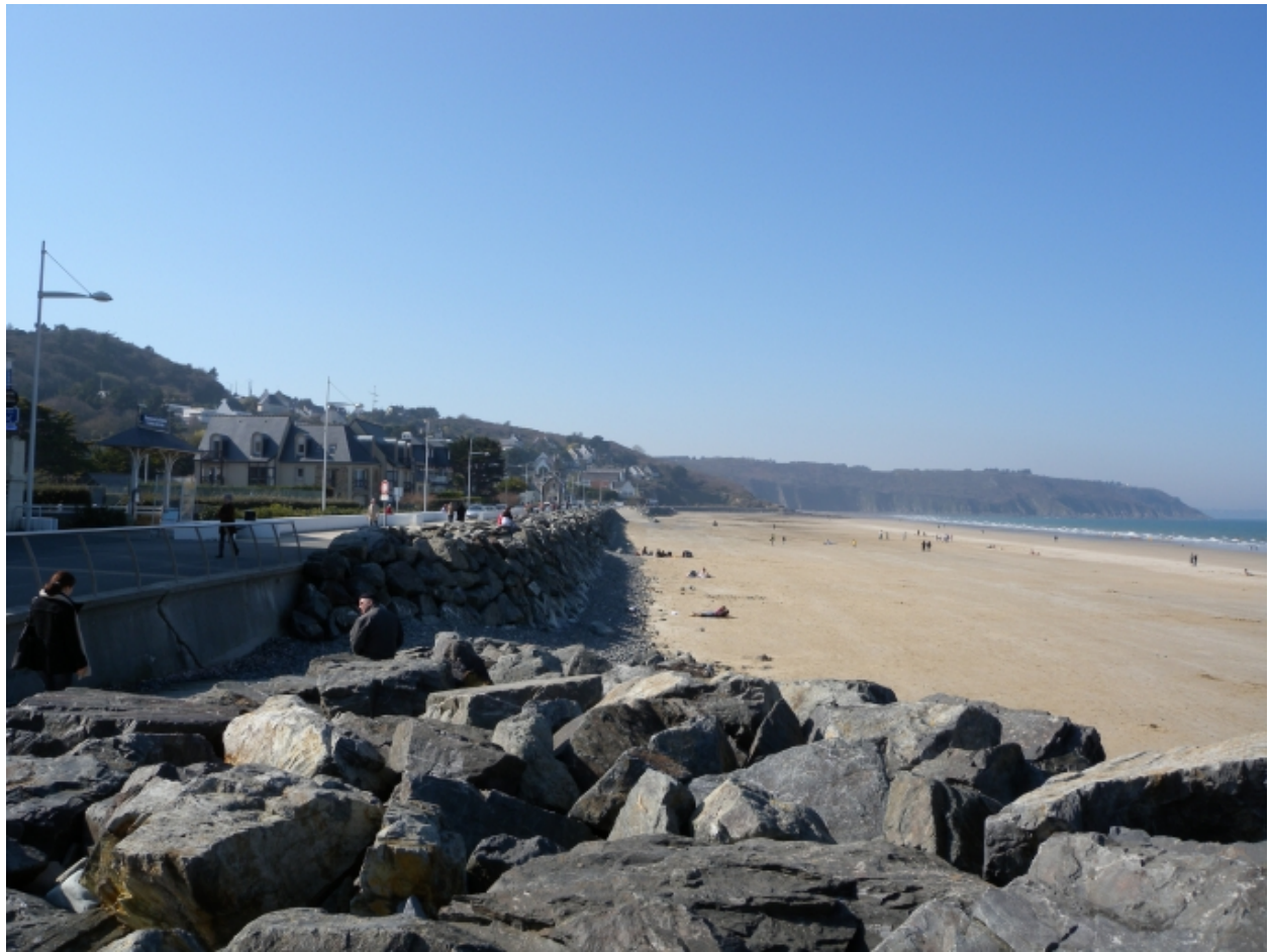
Vue des enrochements devant la digue-promenade
