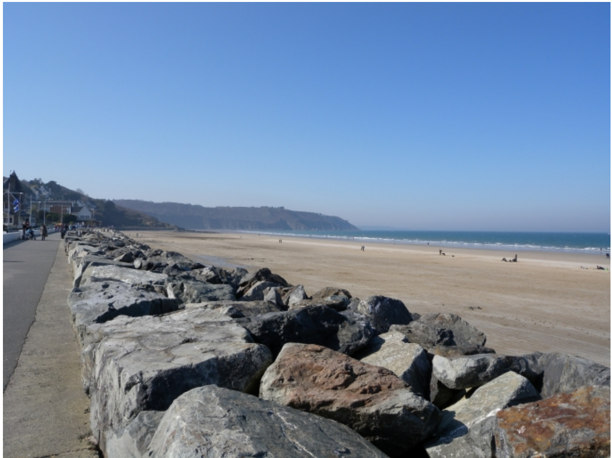
Vue des enrochements devant la digue-promenade
