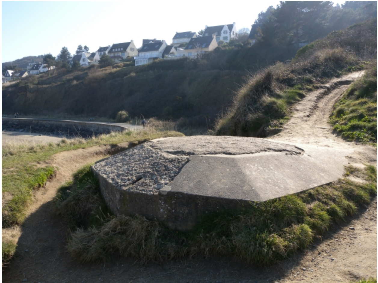
Vue du blockhaus et du front de mer urbanisé en arrière plan (zone pavillonnaire au-dessus de la falaise)
