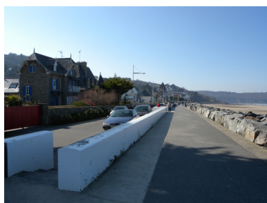
Vue de la digue-promenade en béton avec son corps principal, sur une longueur de 1000 mètres environ Repro. Guy Prigent IVR53_20082213275NUCB
