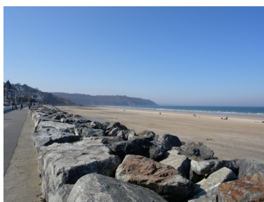
Vue des enrochements devant la digue-promenade Phot. Guy Prigent IVR53_20082213271NUCA
