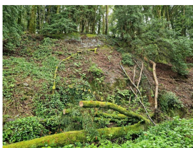
Vue générale depuis le fossé nord. Une partie semble avoir été déroctée/ excavée. Le sommet de la plate- forme est taillé quasi à la verticale Phot. Guillaume Lécueillier IVR53_20252210158NUCA
