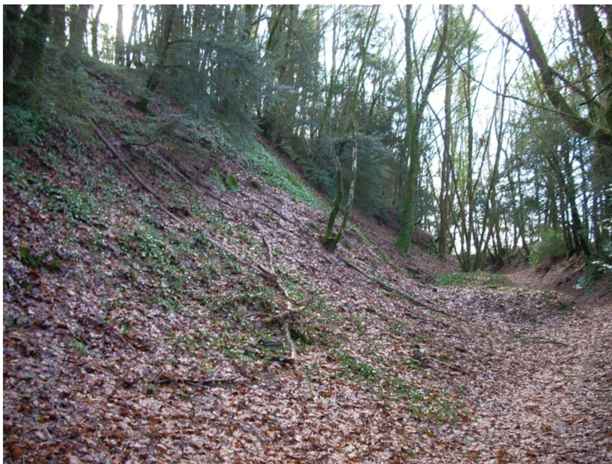
Vue générale (état en 2010). Au premier plan, le fossé
