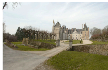
Vue de situation est Phot. Guy Artur, Phot. Norbert Lambart IVR53_20033500931NUCA
