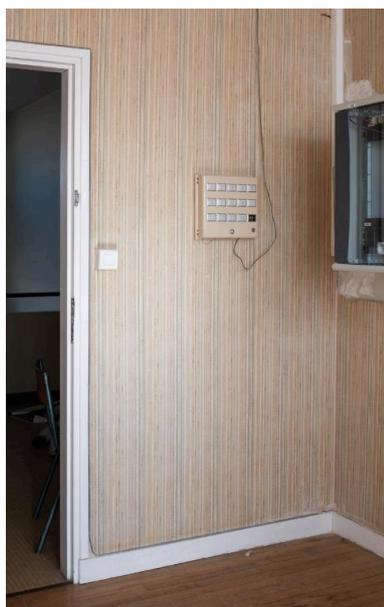
Système d'appel d'urgence pour 15 chambres : vue de situation, à côté de la porte de la salle de garde. L'un des deux tableaux figurant sur les plans (celui des veilleuses sans doute), est absent.
