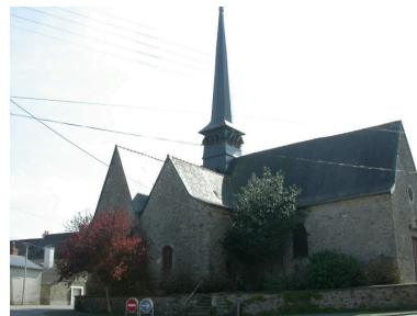
Vue nord Phot. Stéphanie Ménard IVR53_20043505952NUCA
