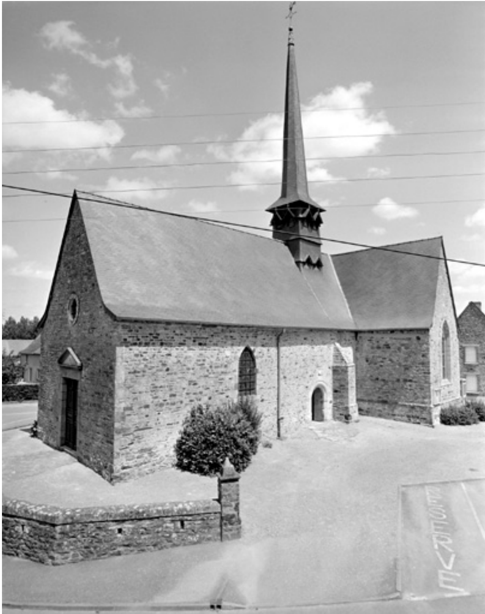
Eglise Saint-Pierre : élévation sud-ouest
