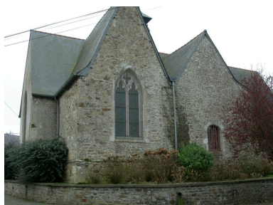
Elévation nord Phot. Stéphanie Ménard IVR53_20043505783NUCA
