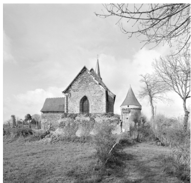
Elévation Est : vue générale Phot. Guy Artur, Phot. Norbert Lambart IVR53_19943500686X
