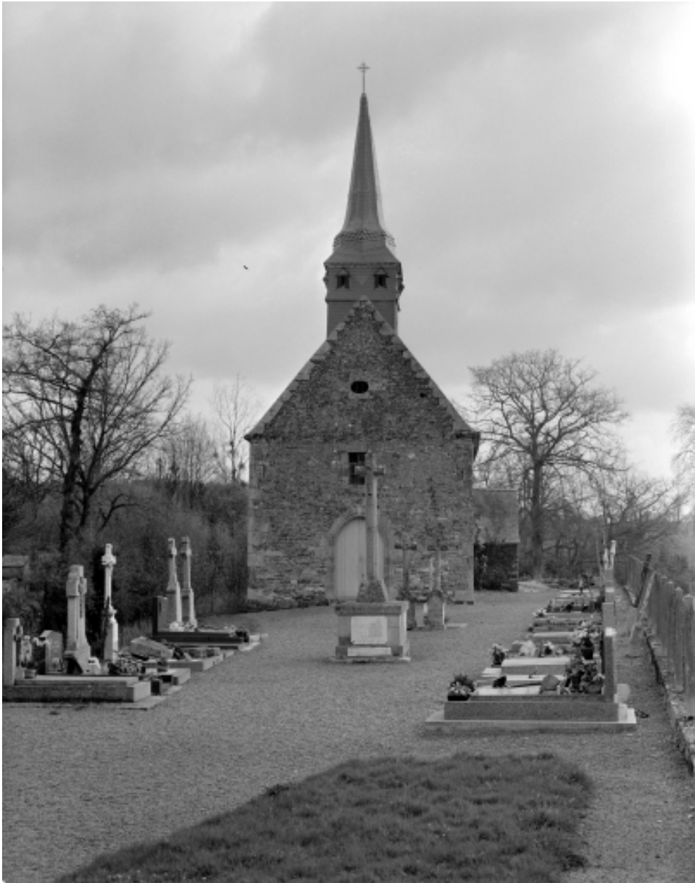
Elévation Ouest : vue générale
