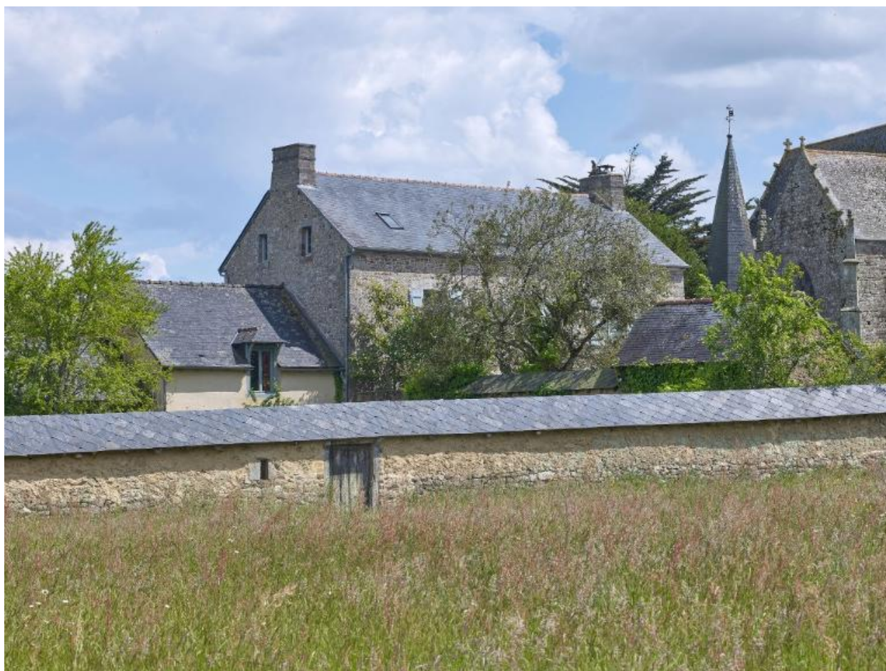
Vue ouest de l'ensemble
