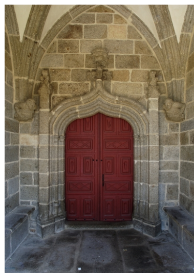
La Feuillée, église paroissiale Saint- Jean-Baptiste : Porche sud, détail Phot. Bernard Bègne IVR53_20062900142NUCA
