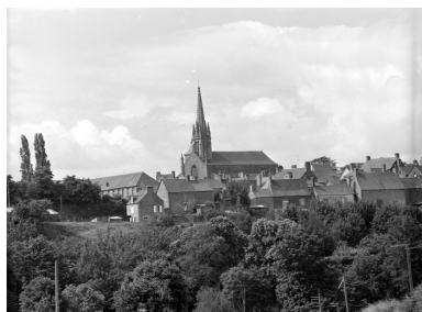
Elévation nord-est : vue de situation Phot. Guy Artur, Phot. Norbert Lambart IVR53_19773500290X
