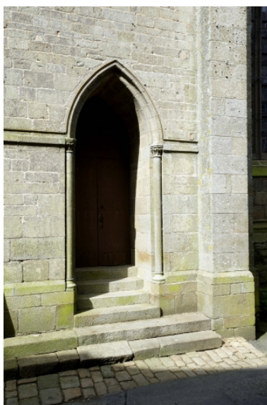
Détail façade ouest Phot. Norbert Lambart IVR53_20113503056NUCA
