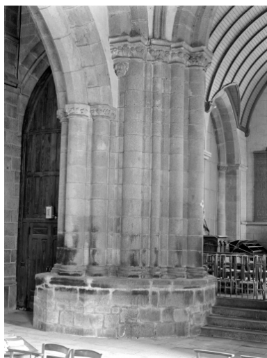
Intérieur, côté sud : pilier 2
