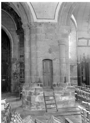
Intérieur, côté sud : pile 3
