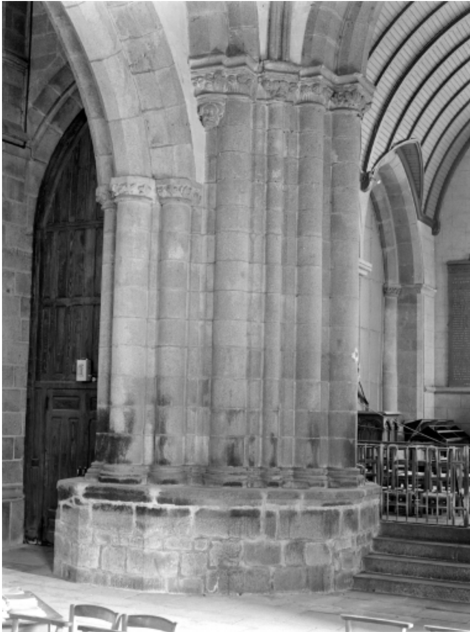
Intérieur, coté sud : pilier 2
