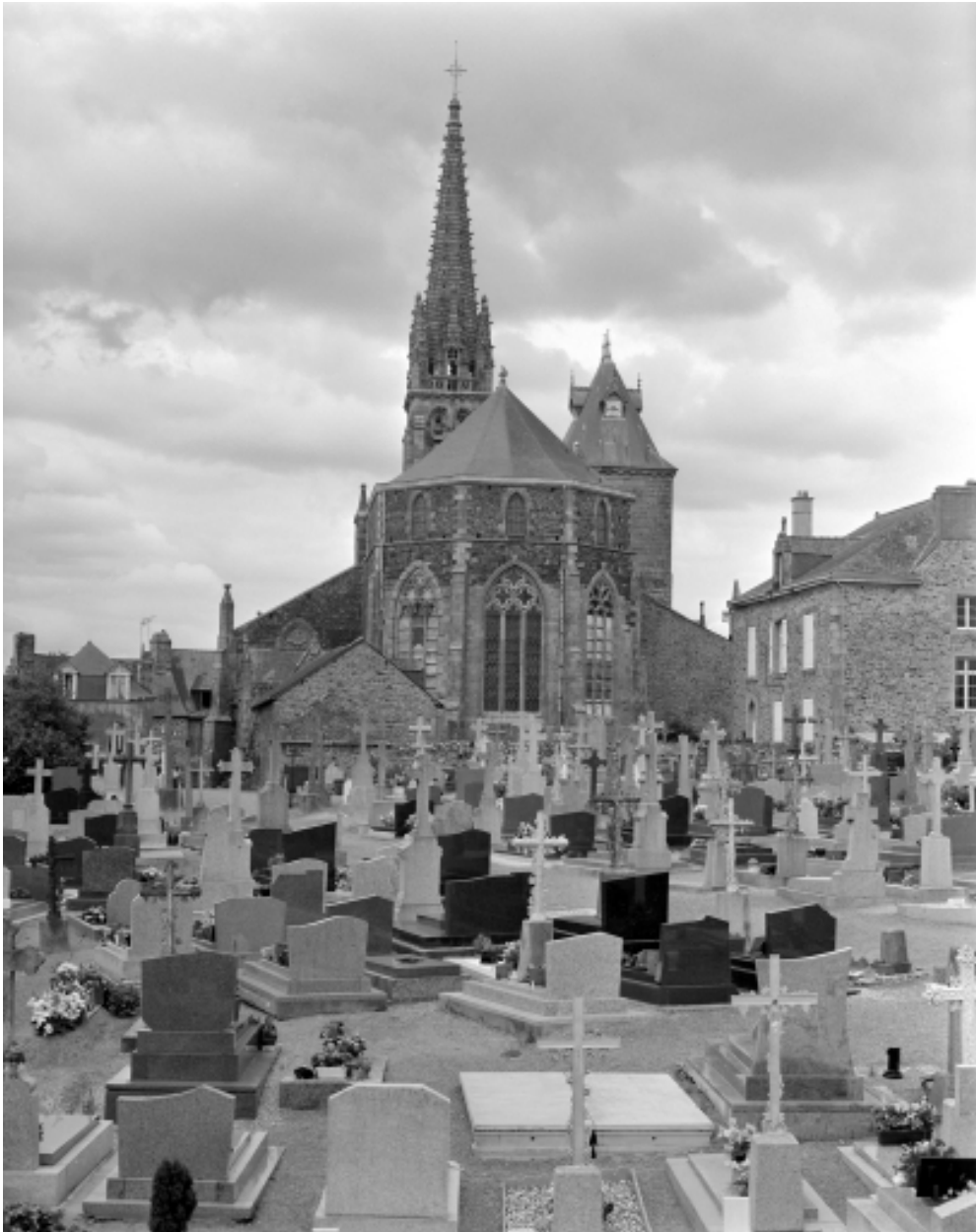
Elévation ouest : vue générale
