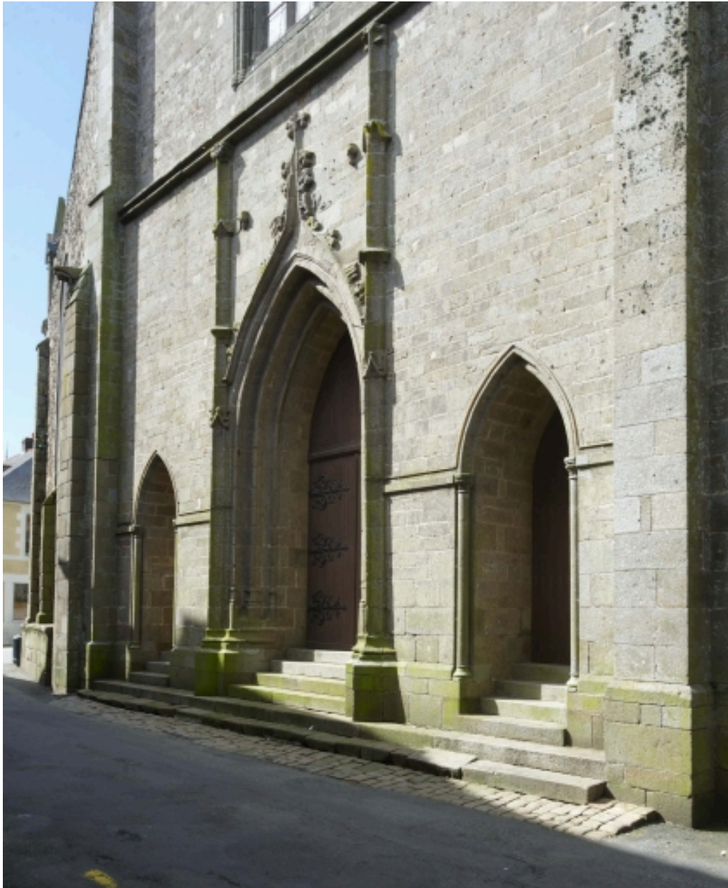
Eglise : portail ouest
