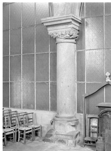
Intérieur, côté sud : pilier 1 Phot. Guy Artur, Phot. Norbert Lambart IVR53_19773500287X
