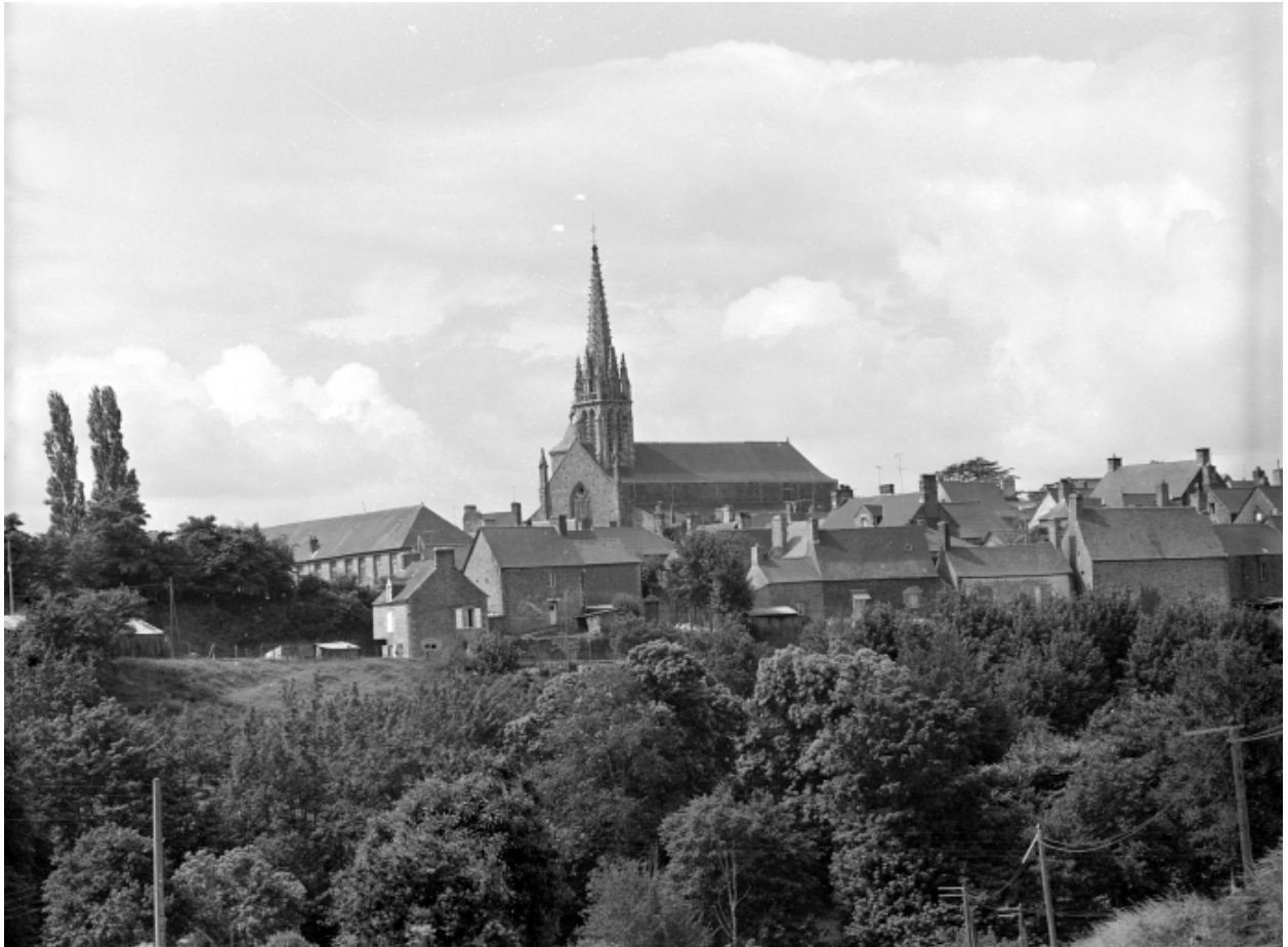
Elévation nord-est : vue de situation
