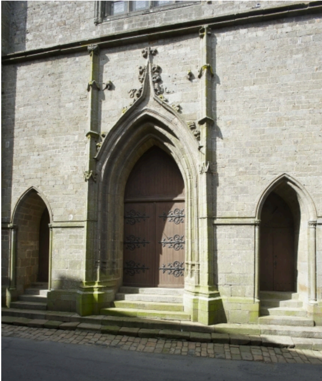
Eglise : porte principale
