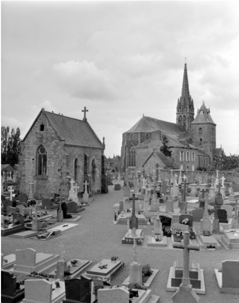
Elévation ouest : vue de situation
