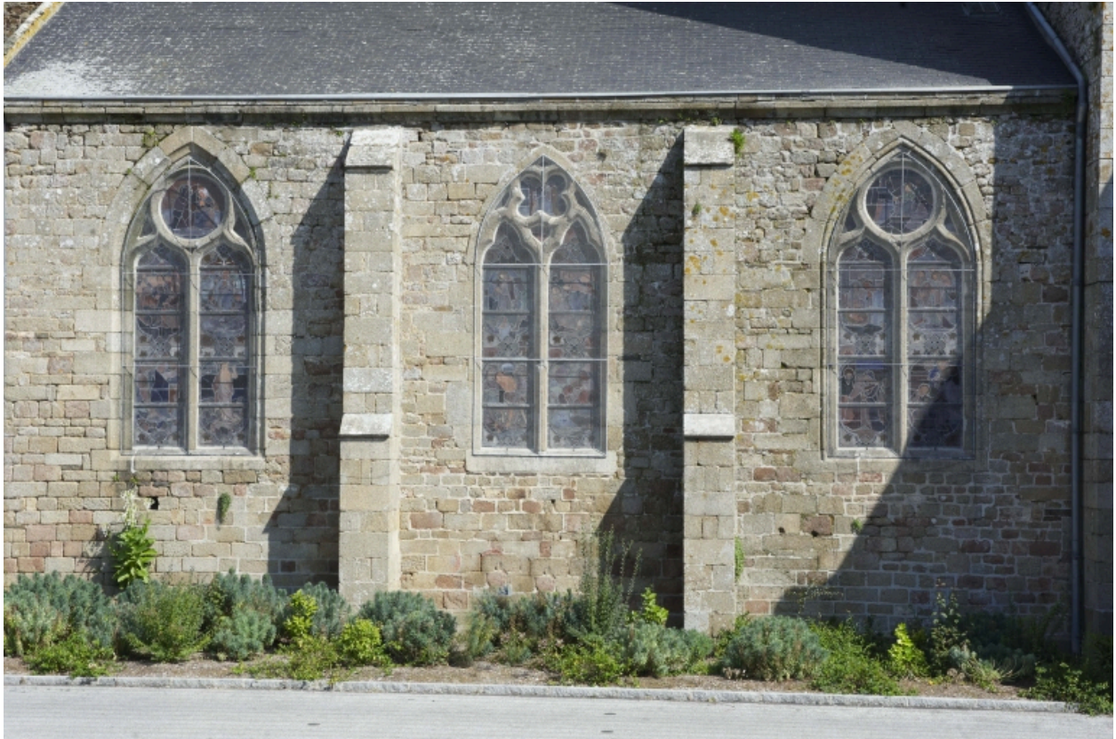
Détail de la façade
