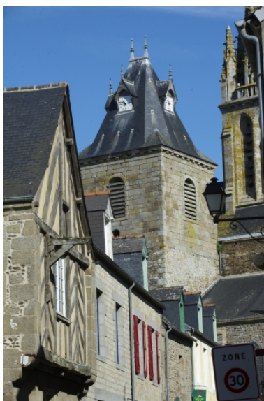
Tour de l'église Phot. Norbert Lambart IVR53_20113503029NUCA
