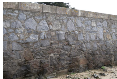
Digue de l'île aux moutons, détail de maçonnerie Phot. Erwana L'Haridon IVR53_20202905384NUCA
