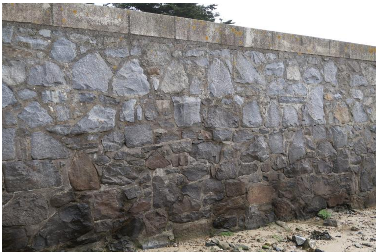
Digue de l'île aux moutons, détail de maçonnerie
