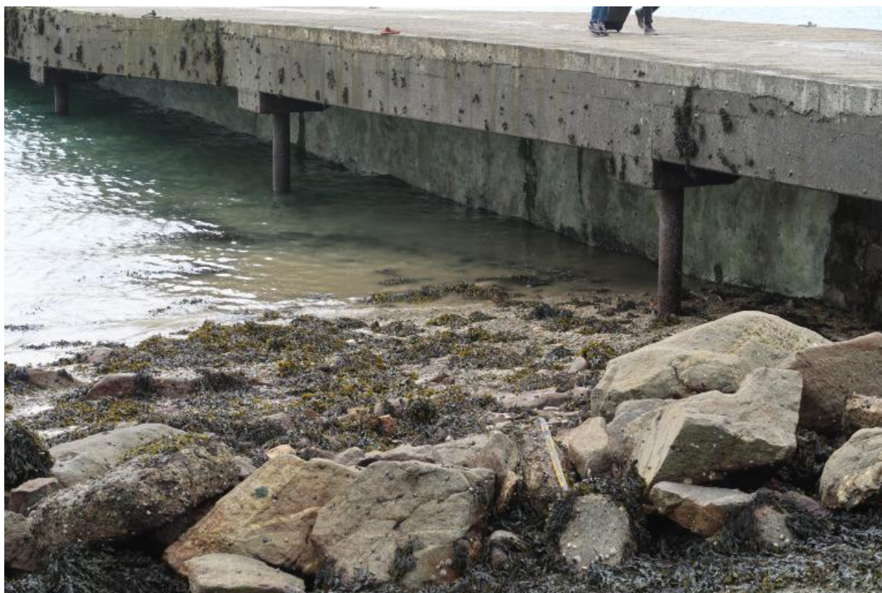
Cale et débarcadère : structure sur pieux (1989)
