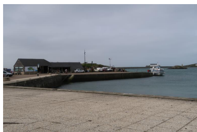
Digue et quai de l'île aux moutons : accostage de la navette Phot. Erwana L'Haridon IVR53_20202905331NUCA
