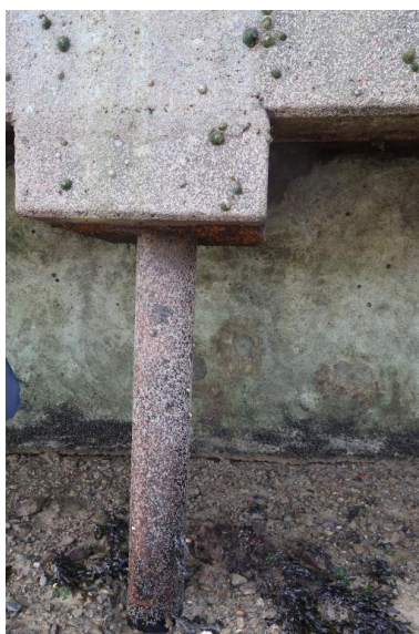
Cale de l'île aux moutons, détail des pieux soutenant l'élargissement de l'infrastructure Phot. Erwana L'Haridon IVR53_20202905274NUCA
