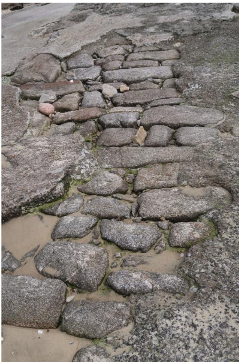
Cale située au nord de la digue, détail platelage (granite issu des rochers de l'anse et ciment)
