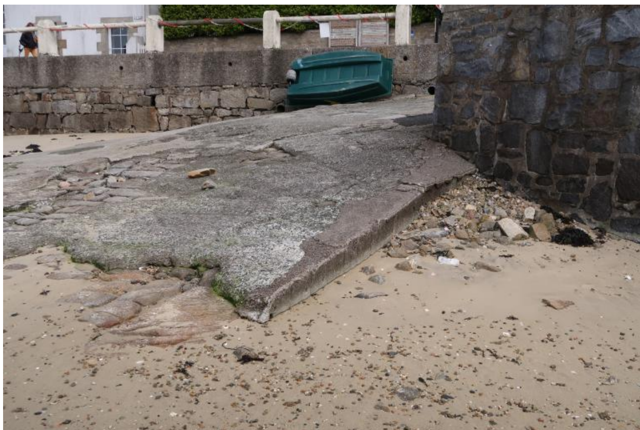
Cale située au nord de la digue
