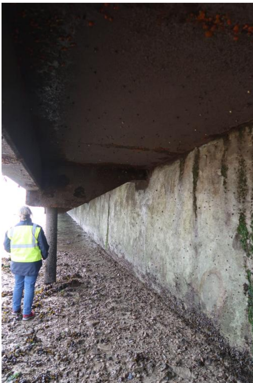
Inspection en avril 2021 de l'infrastructure du débarcadère (prolongement de la cale en 1968-1969)
