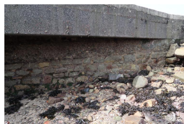
Digue et débarcadère de l'île aux moutons : maçonnerie de l'ancienne cale et couronnement béton suite à l'allongement du débarcadère Phot. Erwana L'Haridon IVR53_20202905363NUCA
