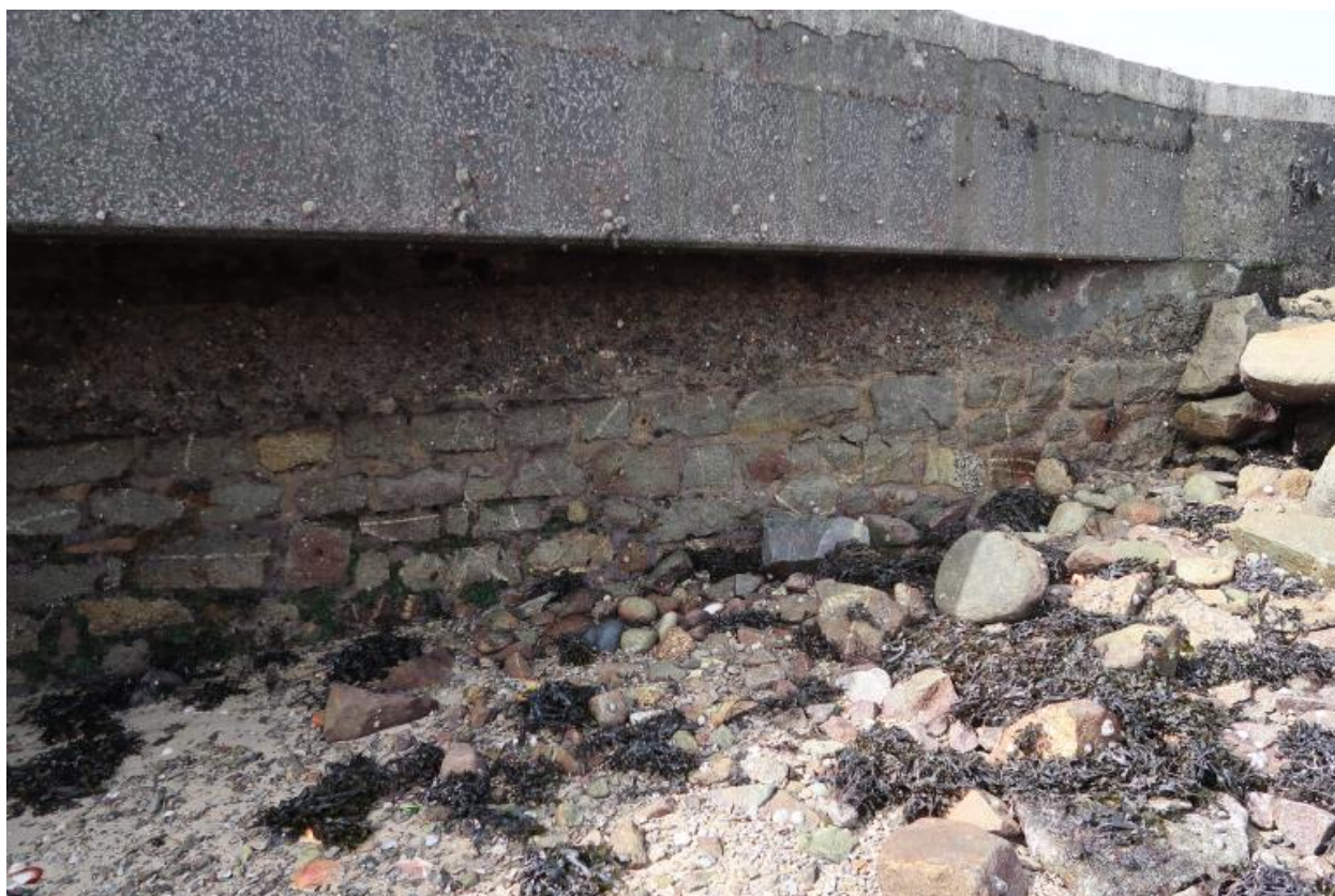
Digue et débarcadère de l'île aux moutons : maçonnerie de l'ancienne cale et couronnement béton suite à l'allongement du débarcadère
