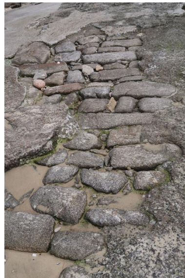
Cale située au nord de la digue, détail platelage (granite issu des rochers de l'anse et ciment) Phot. Erwana L'Haridon IVR53_20202905386NUCA
