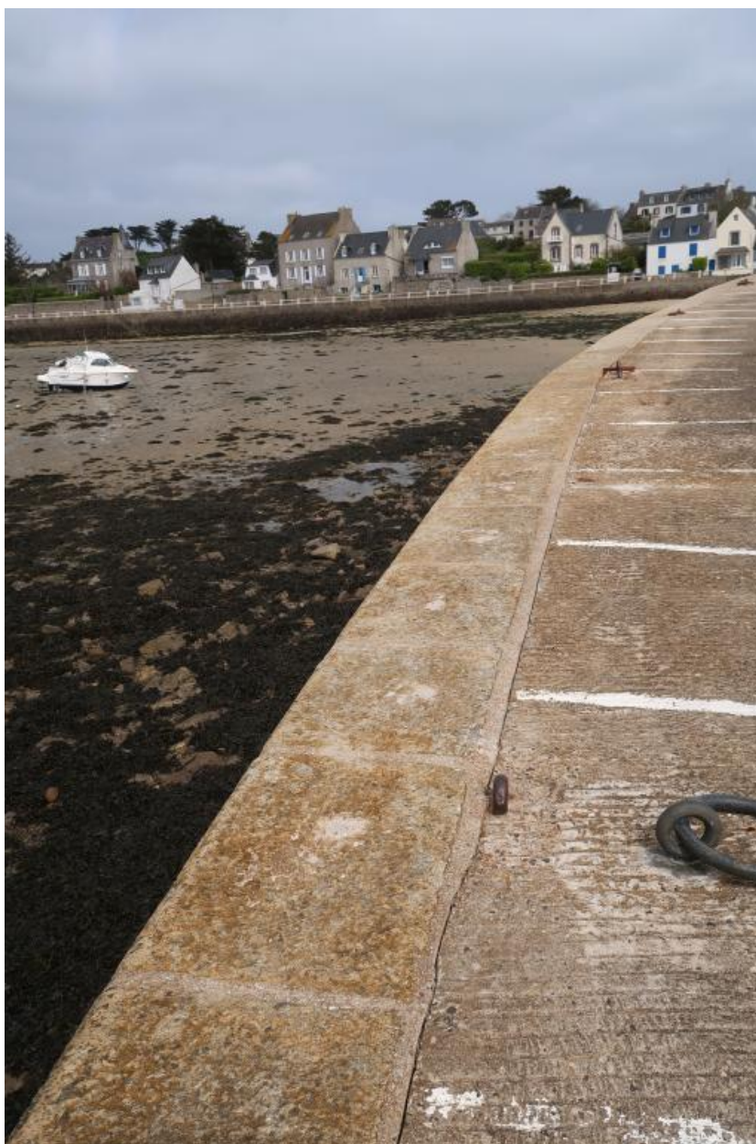
Quai de l'île aux moutons, détail couronnement, granite, pierre de taille
