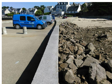
Digue de l'île aux moutons Phot. Région Bretagne IVR53_20202905381NUCA
