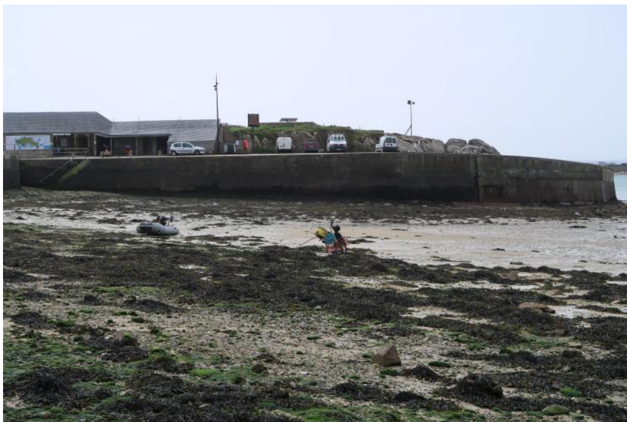
Digue et quai de l'île aux moutons, côté nord
