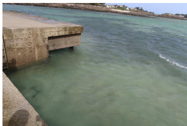
Débarcadère, section élargie, sur pieux Phot. Erwana L'Haridon IVR53_20212905611NUCA
