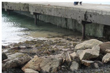
Cale et débarcadère : structure sur pieux (1989) Phot. Erwana L'Haridon IVR53_20202905369NUCA
