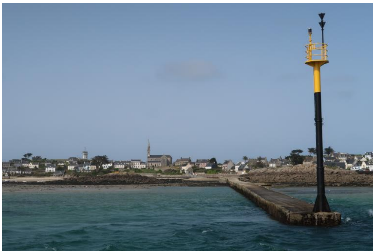
Débarcadère de l'île de Batz entre l'île aux moutons et l'île Kernog, tourelle cardinale sud au bout du débarcadère
