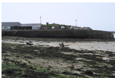
Digue et quai de l'île aux moutons, côté nord Phot. Erwana L'Haridon IVR53_20202905383NUCA
