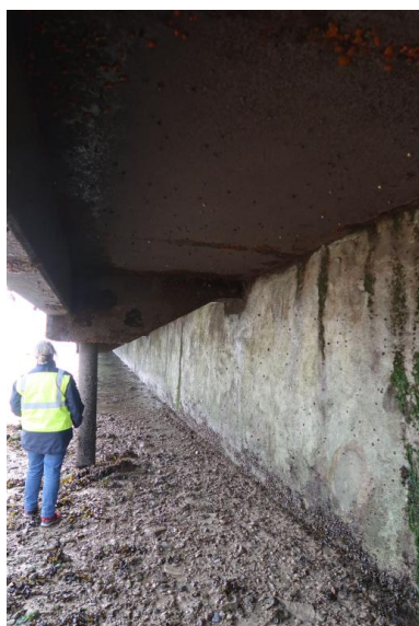
Inspection en avril 2021 de l'infrastructure du débarcadère (prolongement de la cale en 1968-1969) Phot. Erwana L'Haridon
