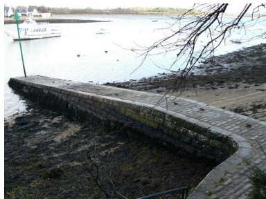
Vue générale de la cale de passage de Barrarac'h Phot. Julien Amghar IVR53_20085606134NUCA
