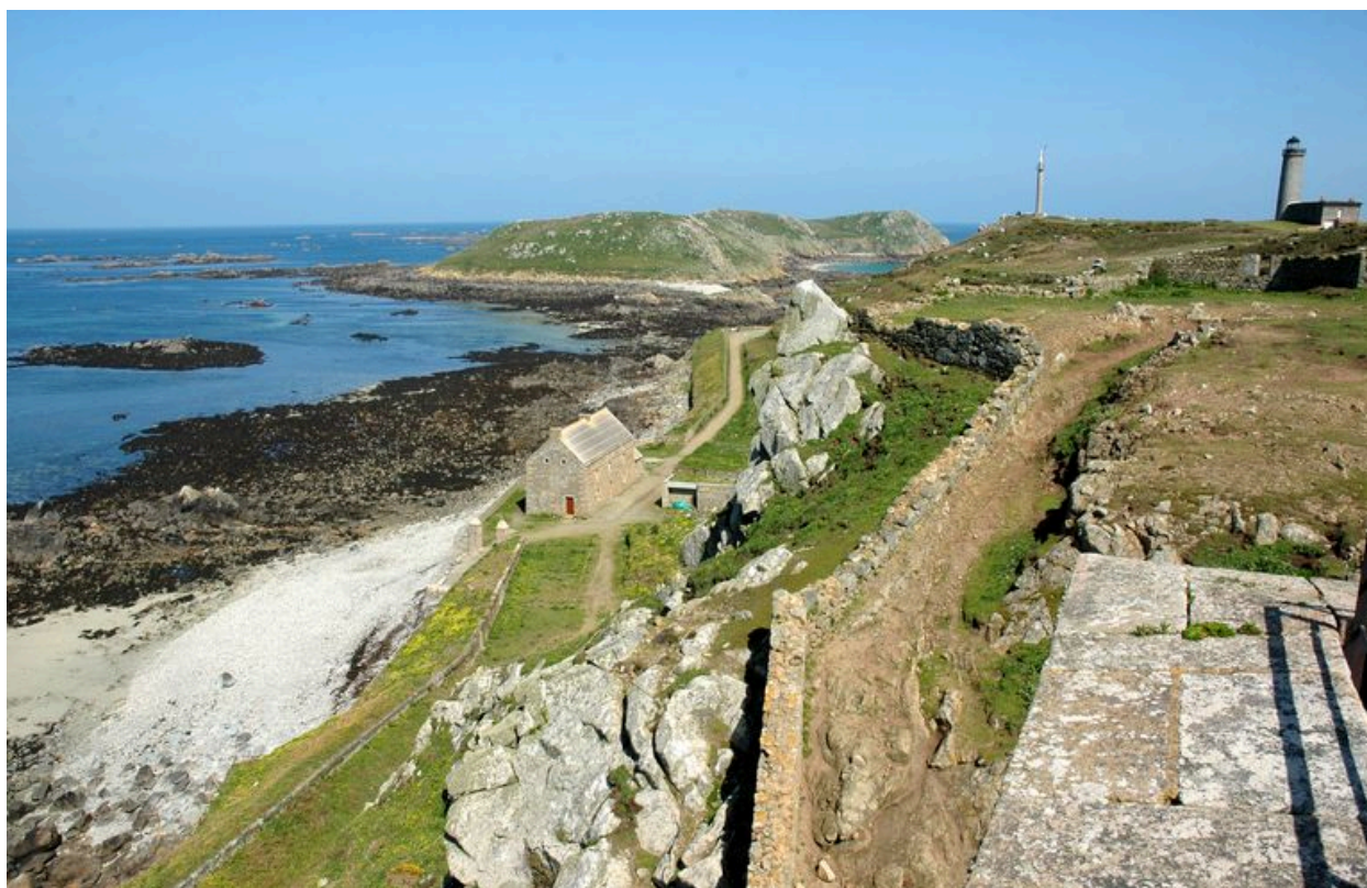
Vue de situation (état en 2006)
