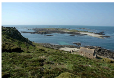
Vue de situation (état en 2006) La cale donne accès au mouillage entre l'Île aux Moines et l'Île Plate Phot. Guillaume Lécueillier IVR53_20062210054NUCA
