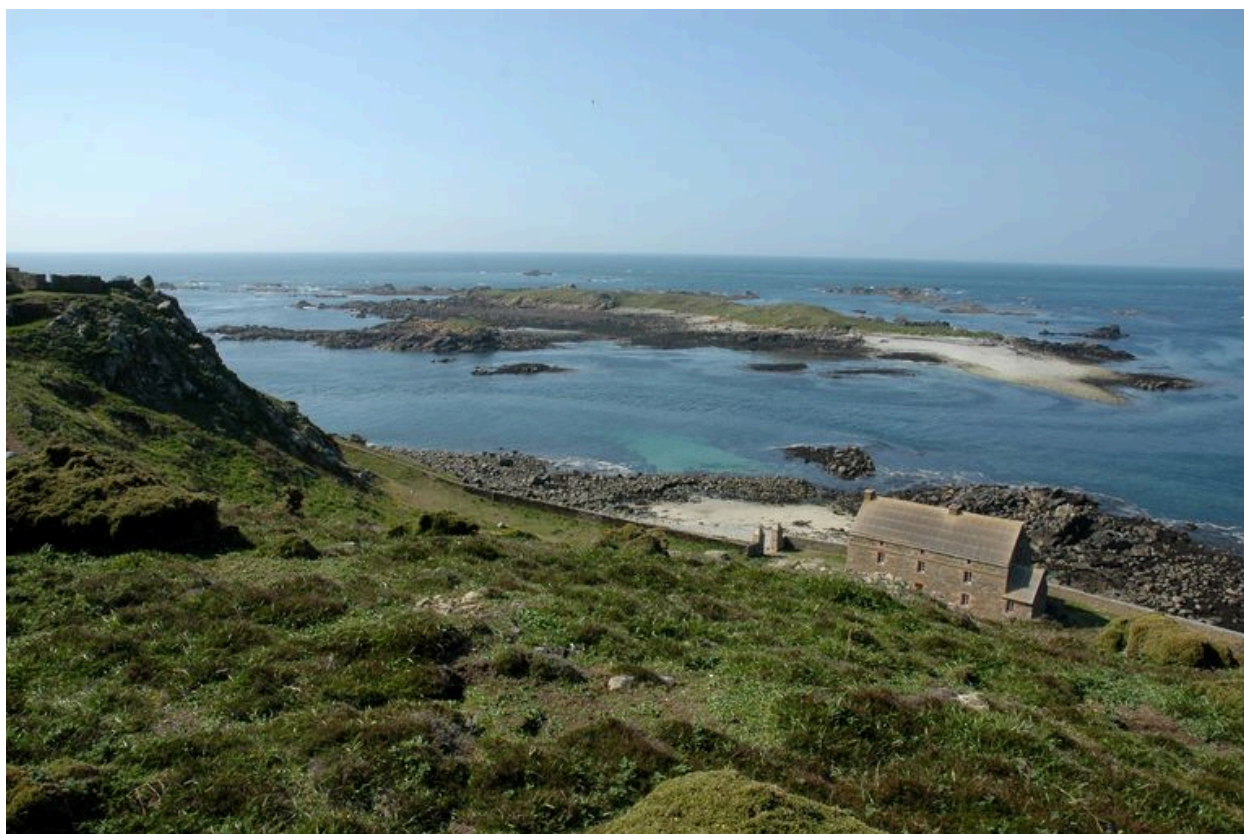
Vue de situation (état en 2006) La cale donne accès au mouillage entre l'Île aux Moines et l'Île Plate
