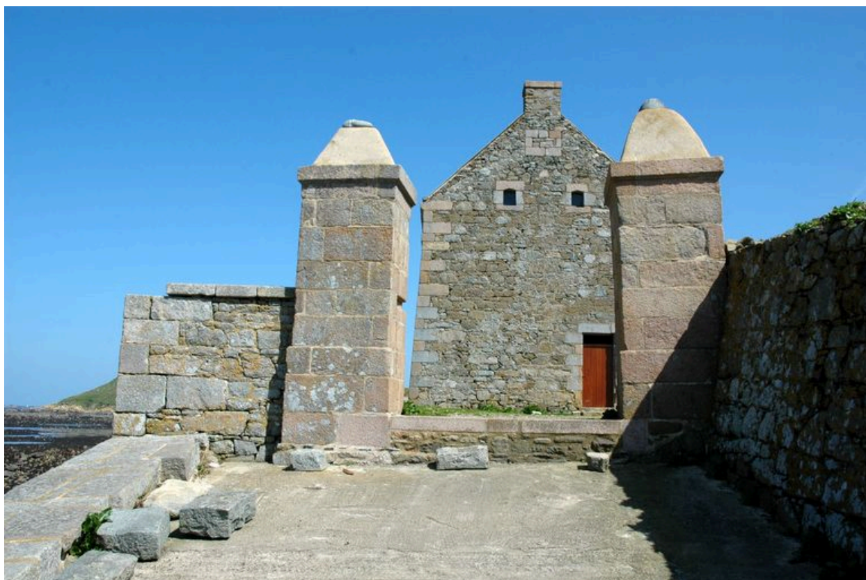
Vue générale (état en 2006). Au premier plan, la cale. En arrière-plan, la caserne
