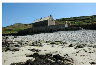
Vue de situation depuis la grève (état en 2006) Phot. Guillaume Lécueillier IVR53_20062210048NUCA
