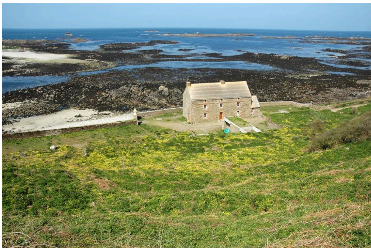
Vue de situation (état en 2006)
