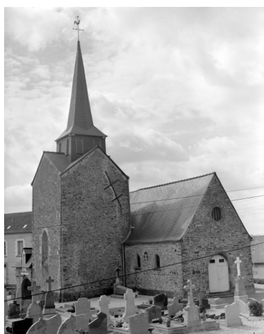
Elévation Nord-Ouest : vue générale
