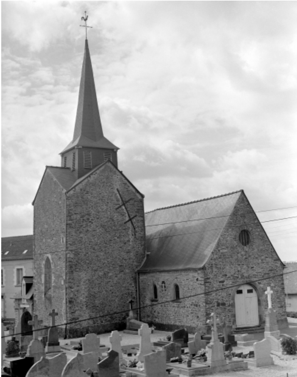
Elévation Nord-Ouest : vue générale
