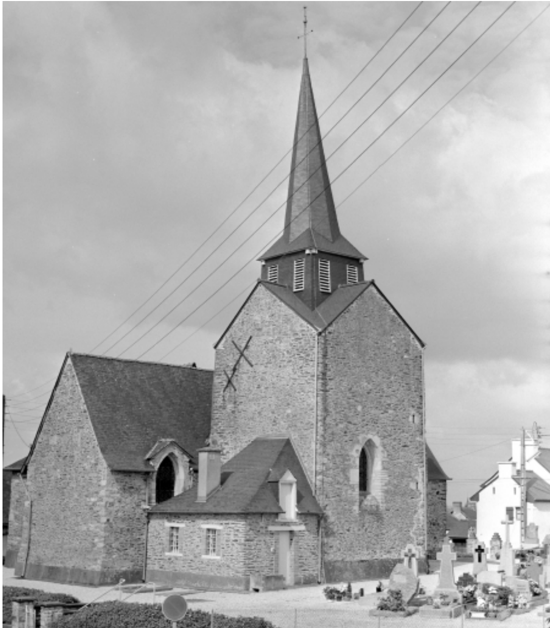
Elévation Nord-Est : vue générale
