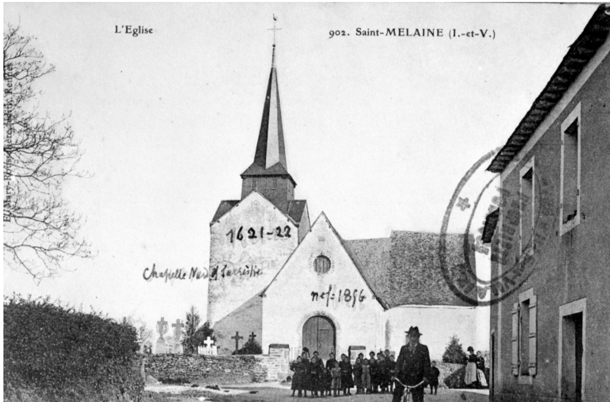
Elévation Ouest : vue générale (Carte postale ancienne, AD35 : 6Fi)
