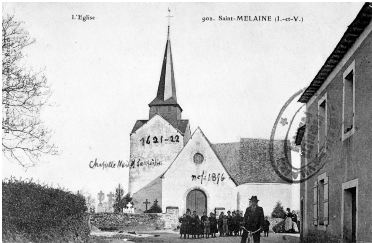
Elévation Ouest : vue générale (Carte postale ancienne, AD35 : 6Fi)
