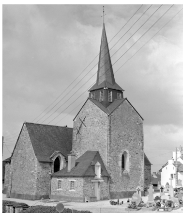
Elévation Nord-Est : vue générale
