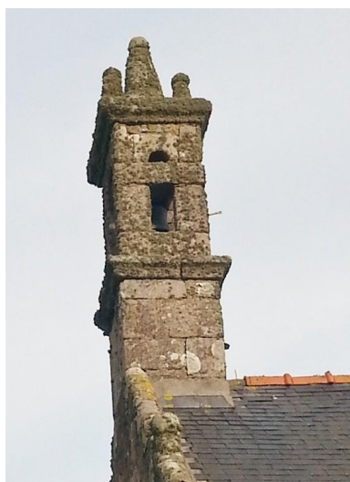
Chapelle de Brouennou Phot. Auteur inconnu IVR53_20242911401NUCA
