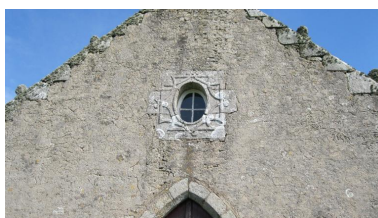
Chapelle de Brouennou Phot. Auteur inconnu IVR53_20242911400NUCA
