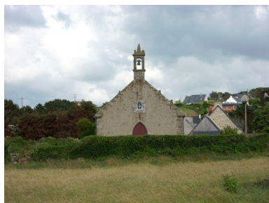
Landéda, chapelle du Brouennou : élévation ouest Phot. Gwénaél Fauchille IVR53_20082906080NUCA
