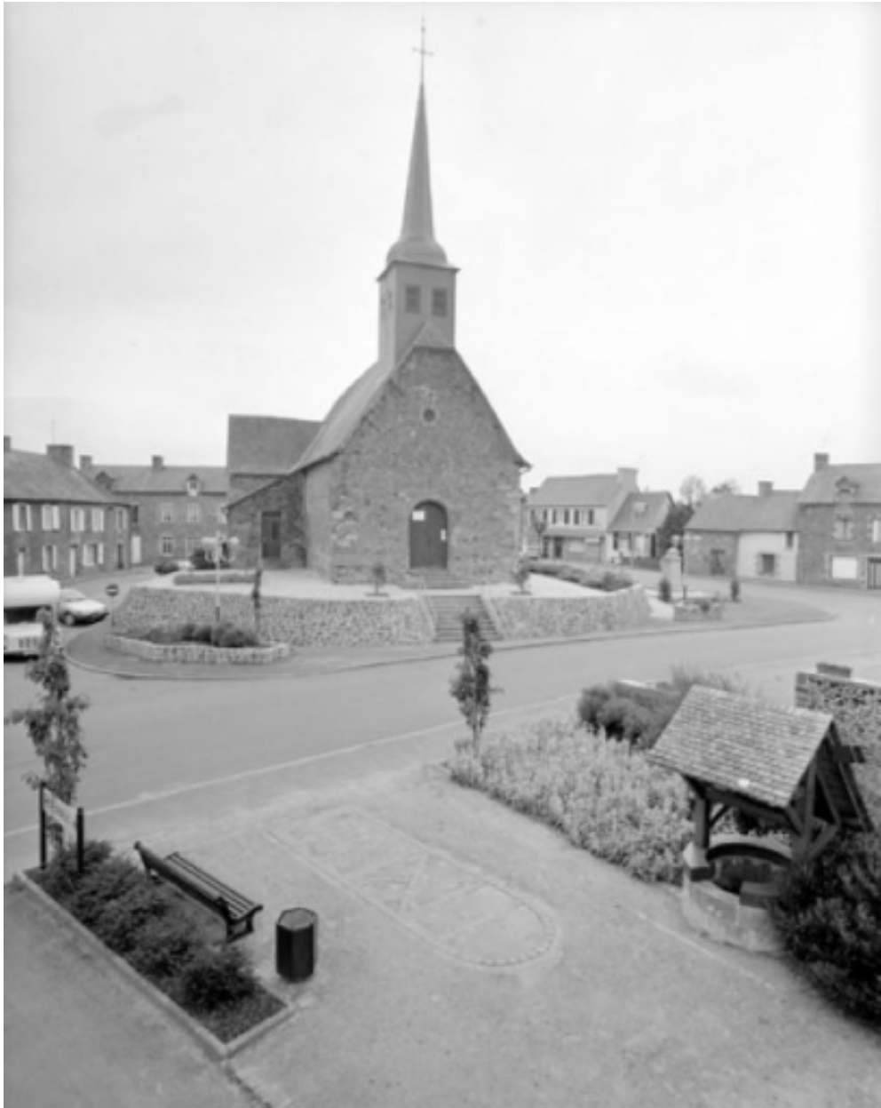
Elévation ouest : vue générale
