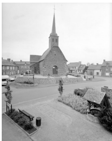
Elévation ouest : vue générale Phot. Guy Artur, Phot. Norbert Lambart IVR53_19943500893X
