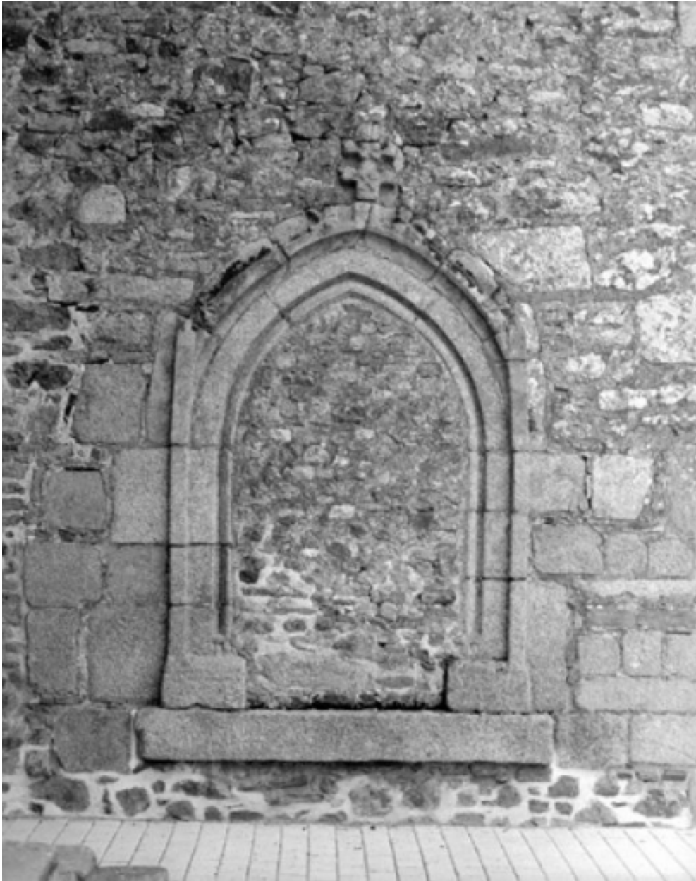
Elévation sud, bras du transept, ancienne porte ouest : vue générale
