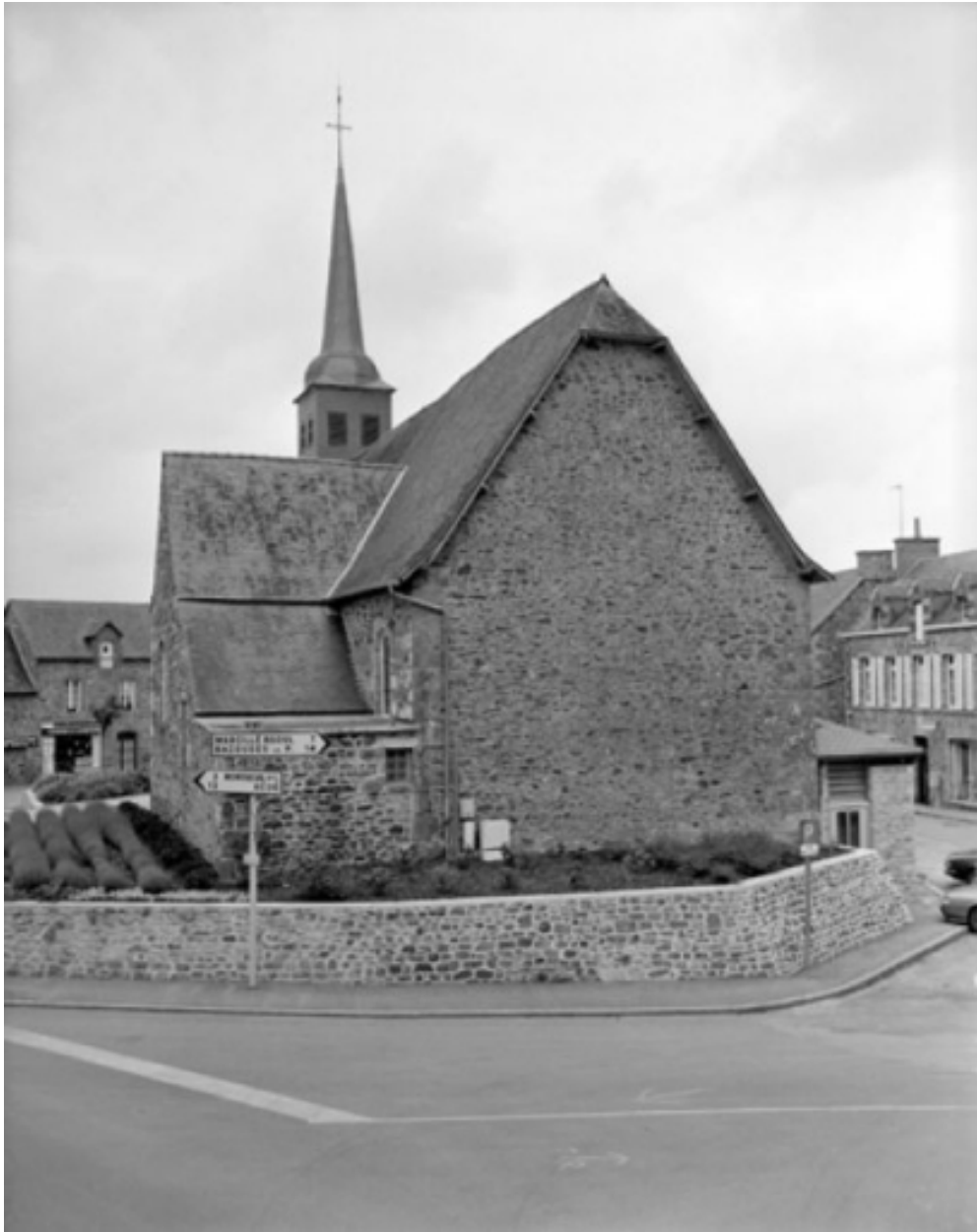
Elévation est : vue générale
