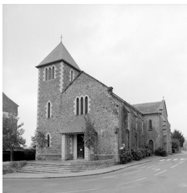
Elévation Ouest : vue générale Phot. Bernard Bègne, Phot. M. Loyon IVR53_19923500833X
