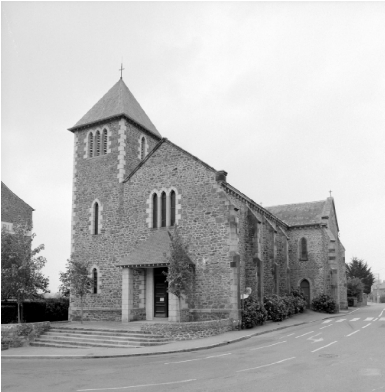
Elévation Ouest : vue générale
