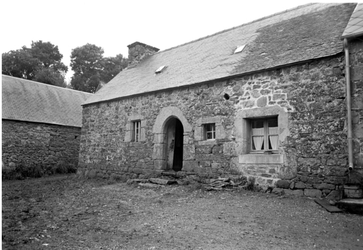
Maison (Kergadoret) : façade principale
