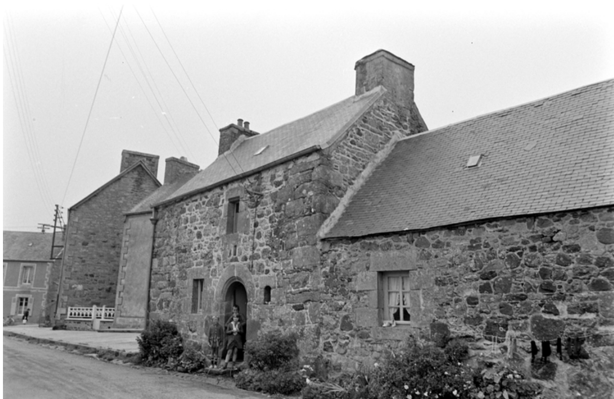
Ferme (La Roche) : vue générale de la face sud
