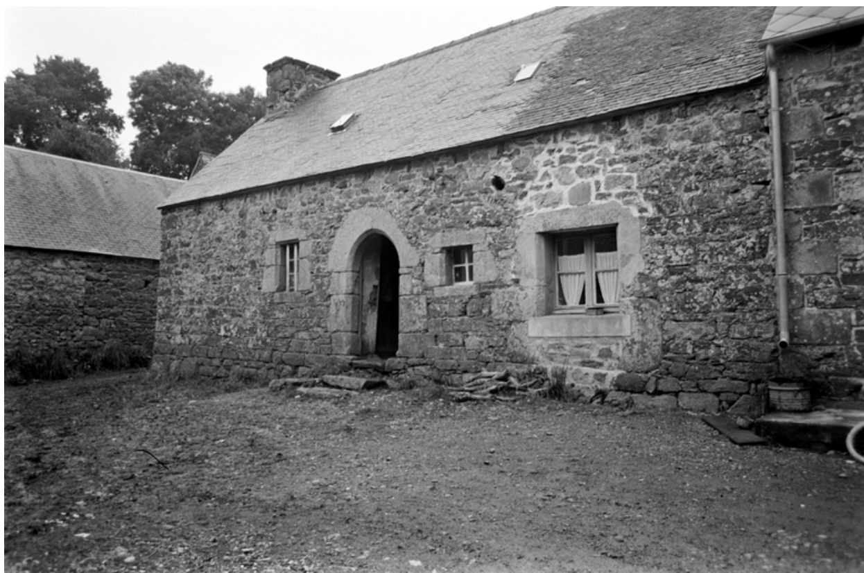
Maison (Kergadoret) : façade principale
