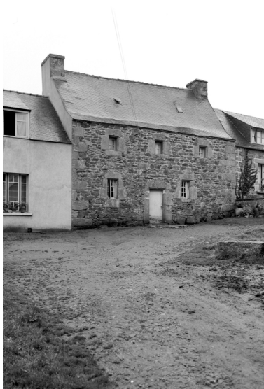
Maison (Kermenguy) : vue générale de la face sud Phot. François Dagorn IVR53_19682201870X
