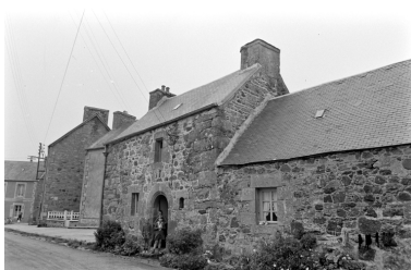
Ferme (La Roche) : vue générale de la face sud Phot. Didier Cadiou IVR53_19682202027Z
