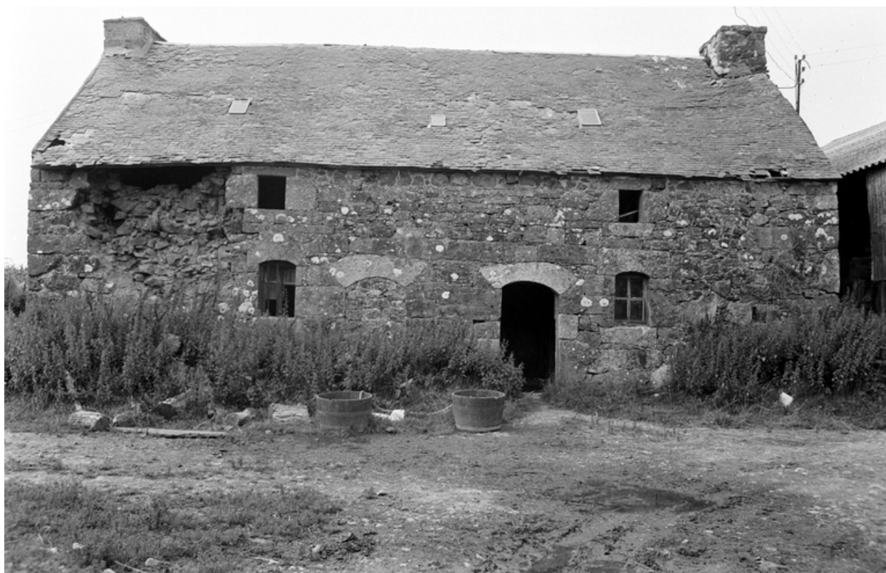
Maison (Kerblouz) datée 1807 : vue générale
