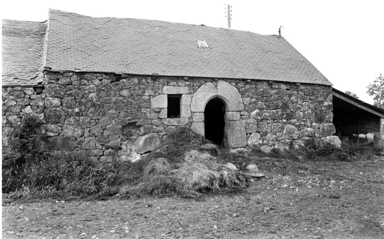
Maison (Kerblouz) datée 1801 : vue générale
