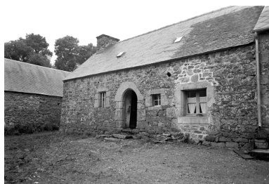
Maison (Kergadoret) : façade principale Phot. Didier Cadiou IVR53_19682202026Z
