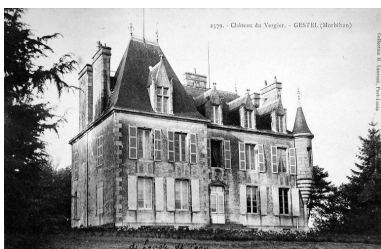
Vue générale Phot. Elise Lauranceau IVR53_20045606230NUCB
