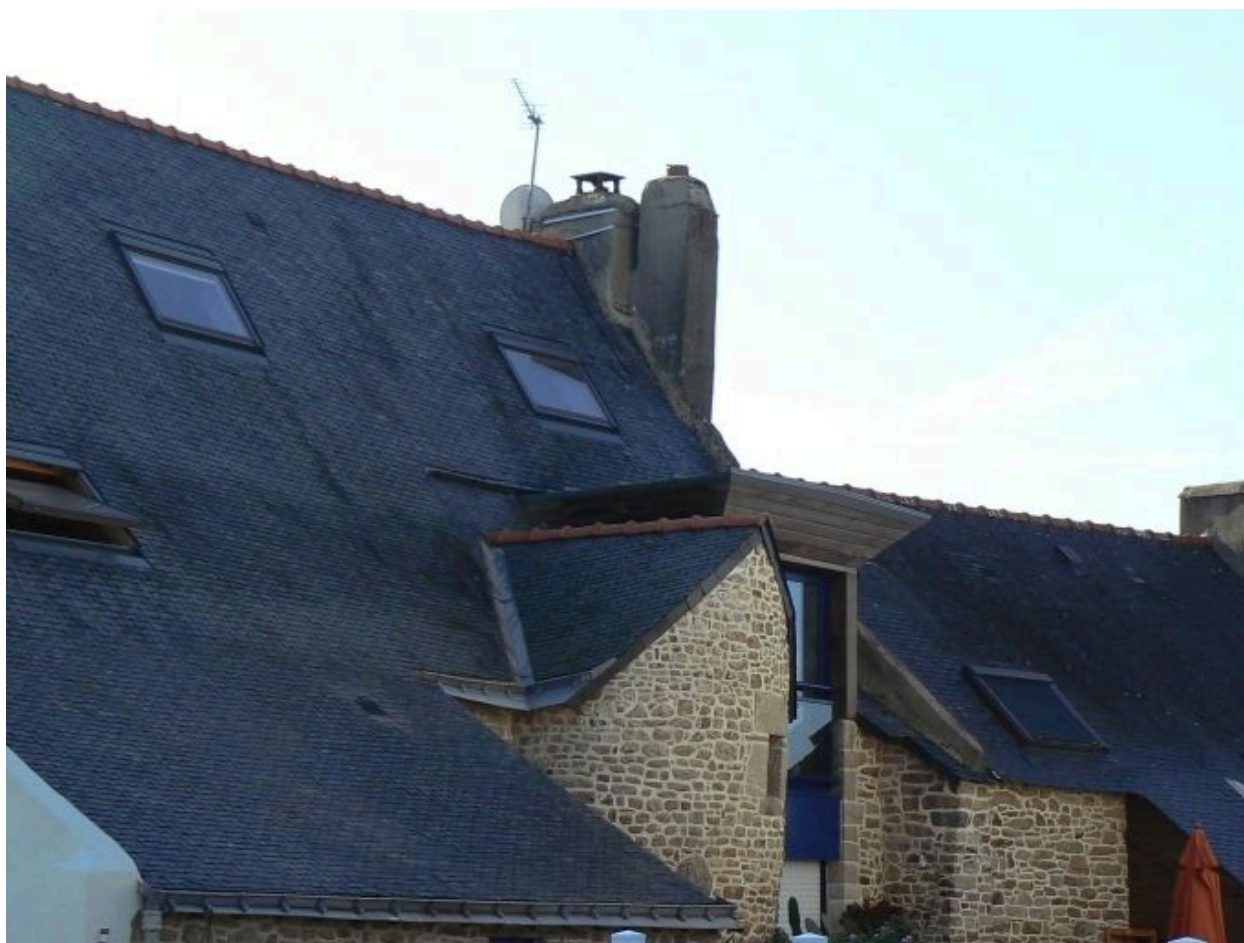
Vue arrière de la maison du 2 rue des Algues avec une tourelle
