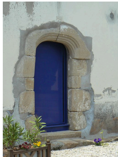
Porte de la maison du 2 rue des Algues Phot. Johan Vincent IVR53_20075605686NUCA
