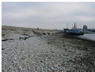
Vue de la digue depuis la grève Phot. Iwan Le Berre IVR53_20062908387NUCA
