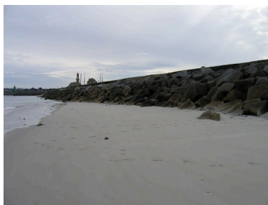
Vue de la digue-route depuis la plage du Corréjou Phot. Guillaume Marie IVR53_20062908395NUCA
