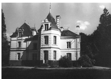
Vue générale nord Phot. Jeannik Le Goux IVR53_19743500635Z
