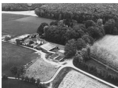
Vue aérienne vers le nord-ouest Phot. G.A.L.A.T. IVR53_19843501908V
