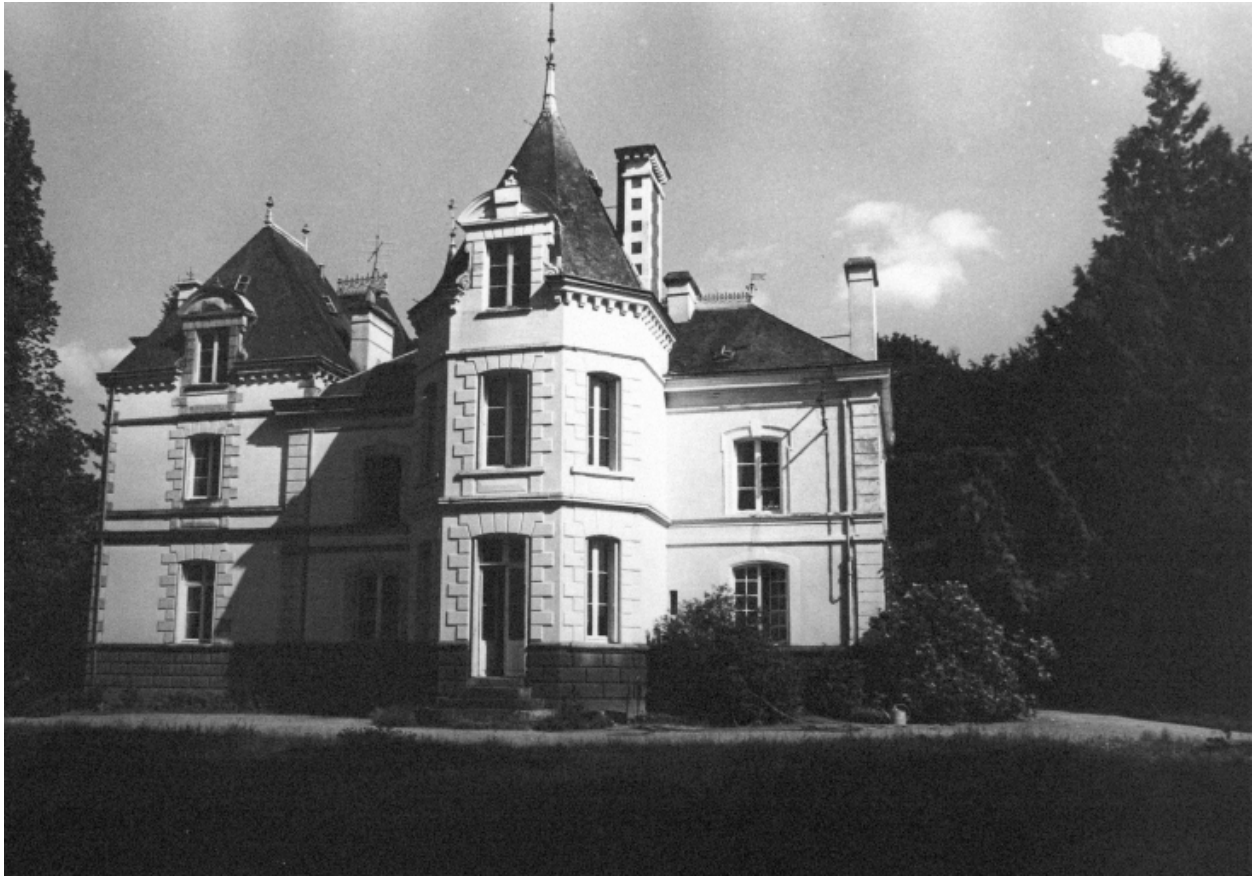
Vue générale nord
