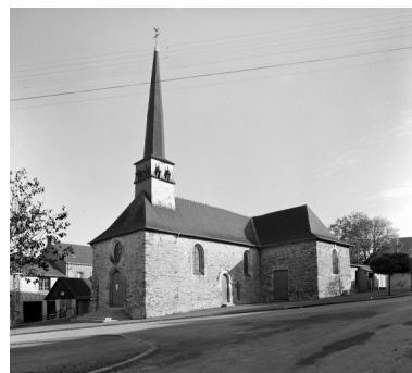
Elévation Sud-Ouest : vue générale Phot. Guy Artur IVR53_19673500084V
