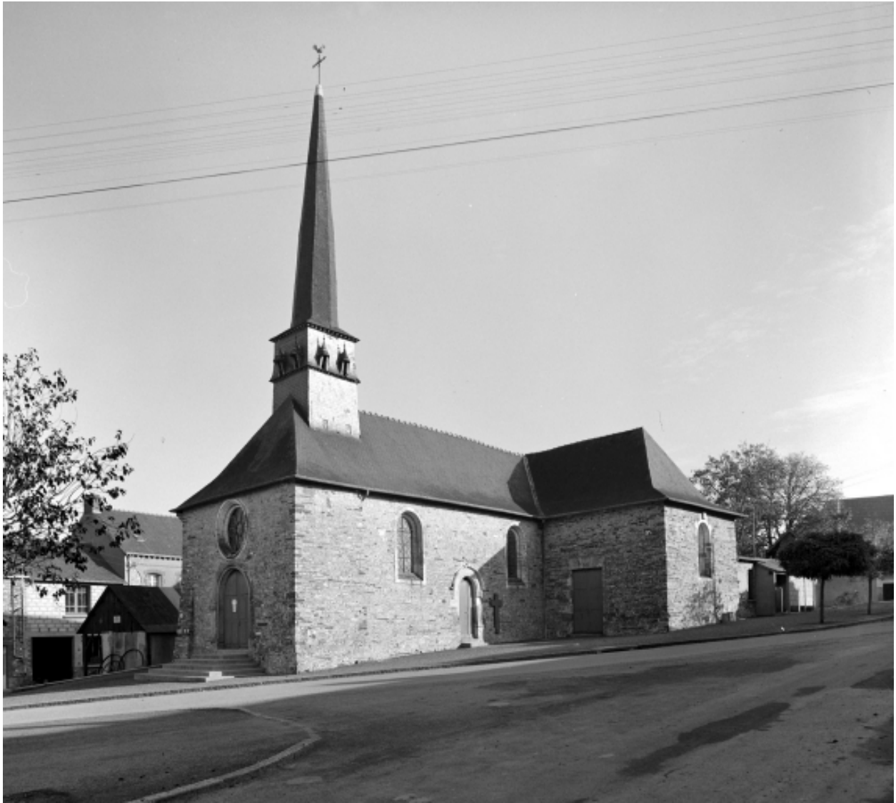
Elévation Sud-Ouest : vue générale
