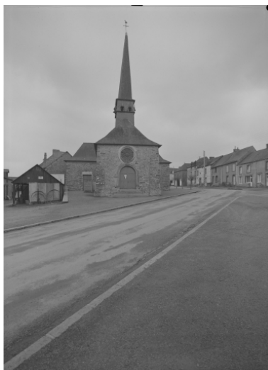
Elévation ouest : vue générale Phot. François Dagorn IVR53_19703500174V
