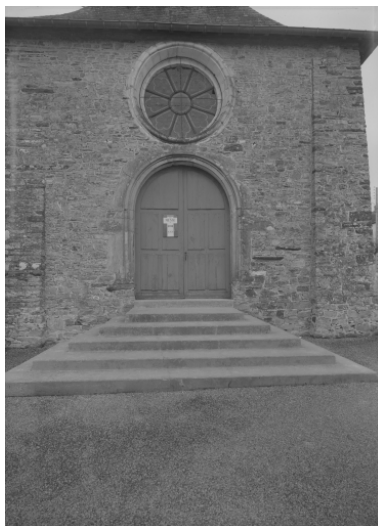
Elévation ouest, porte : vue générale Phot. Guy Artur IVR53_19703500176V
