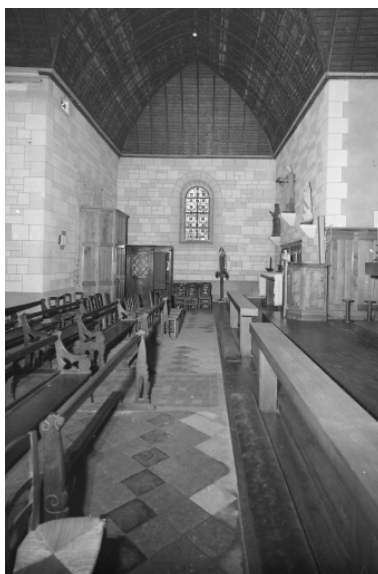
Nef, mur sud, restes d'enfeu. Phot. François Dagorn IVR53_19703500172V
