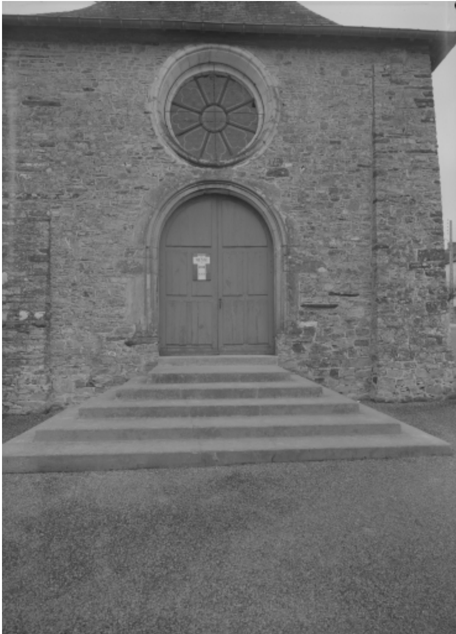
Elévation ouest, porte : vue générale
