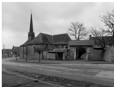
Elévation sud-est : vue générale Phot. François Dagorn IVR53_19703500175V
