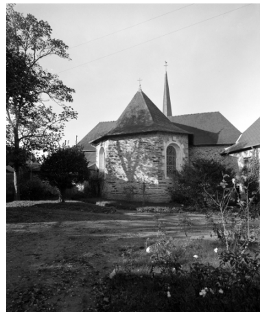
Elévation Est : vue générale Phot. Guy Artur IVR53_19673500083V
