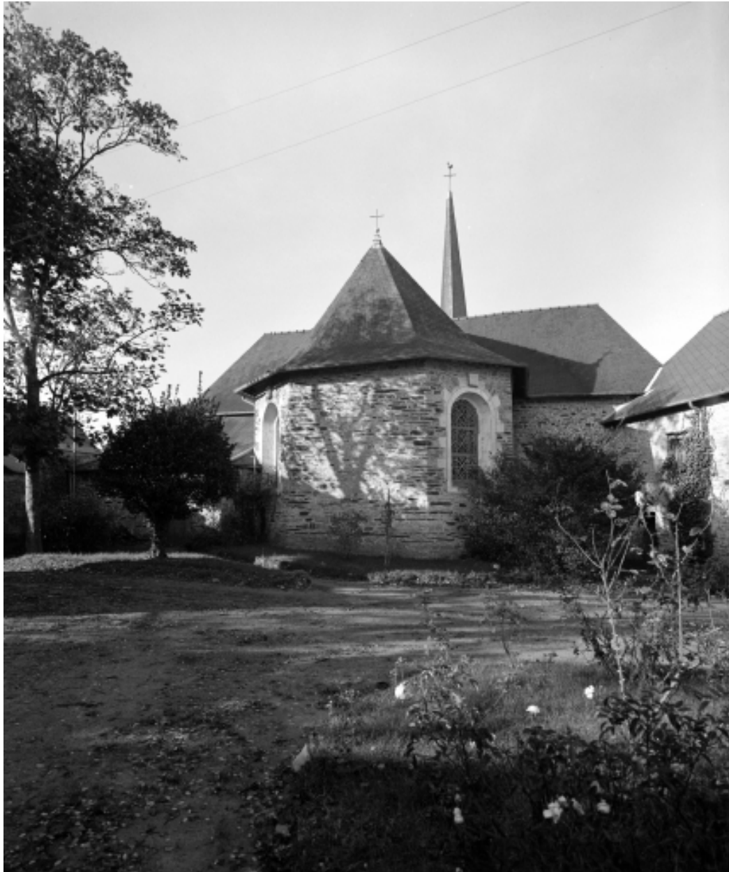
Elévation Est : vue générale
