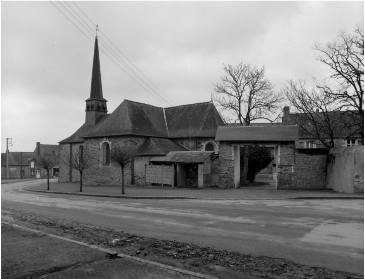
Elévation sud-est : vue générale
