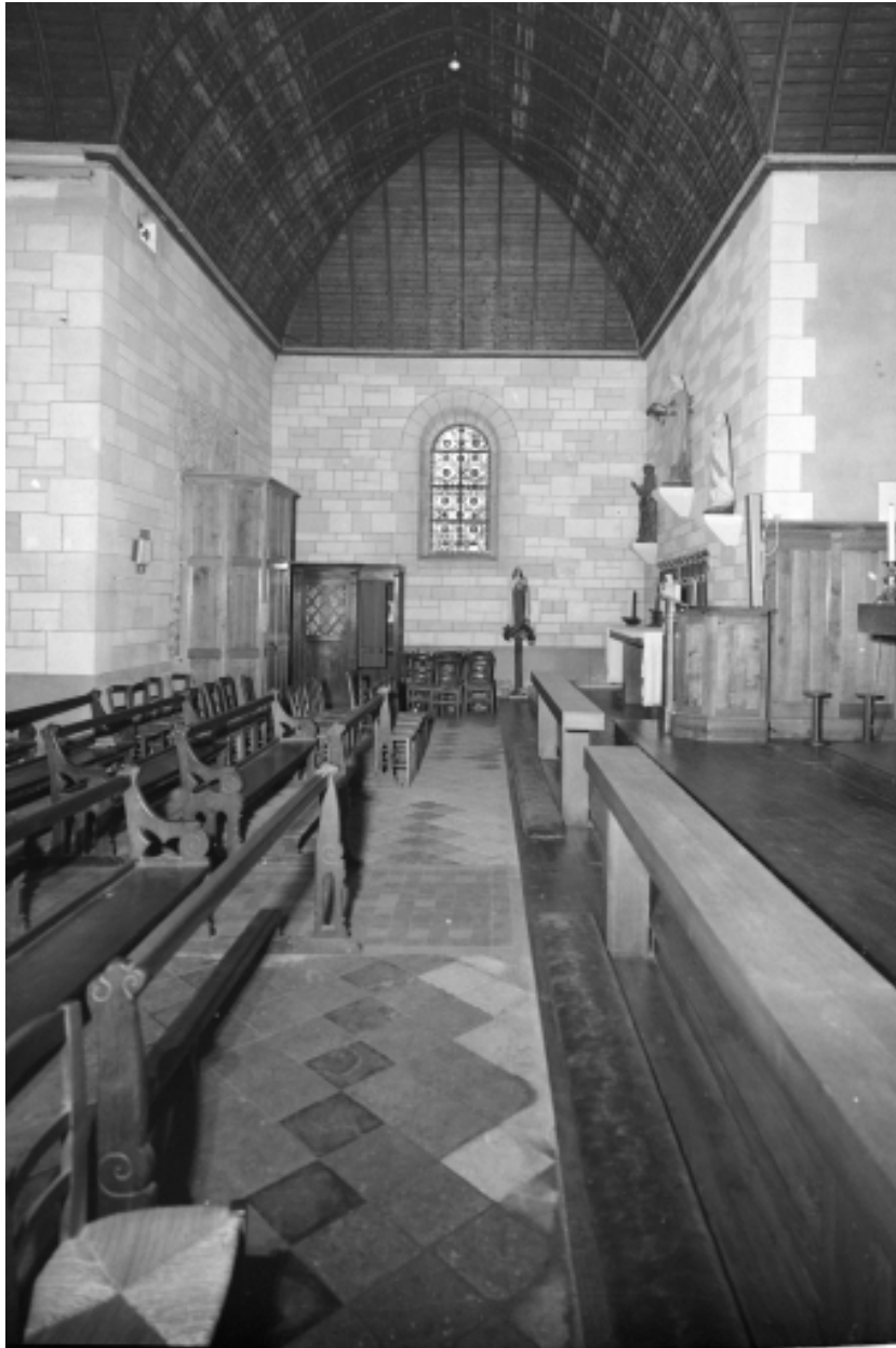
Intérieur, bras Nord du transept : vue générale.
