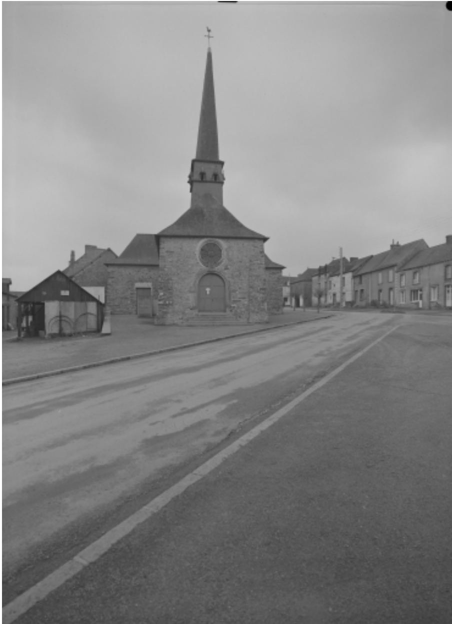
Elévation ouest : vue générale
