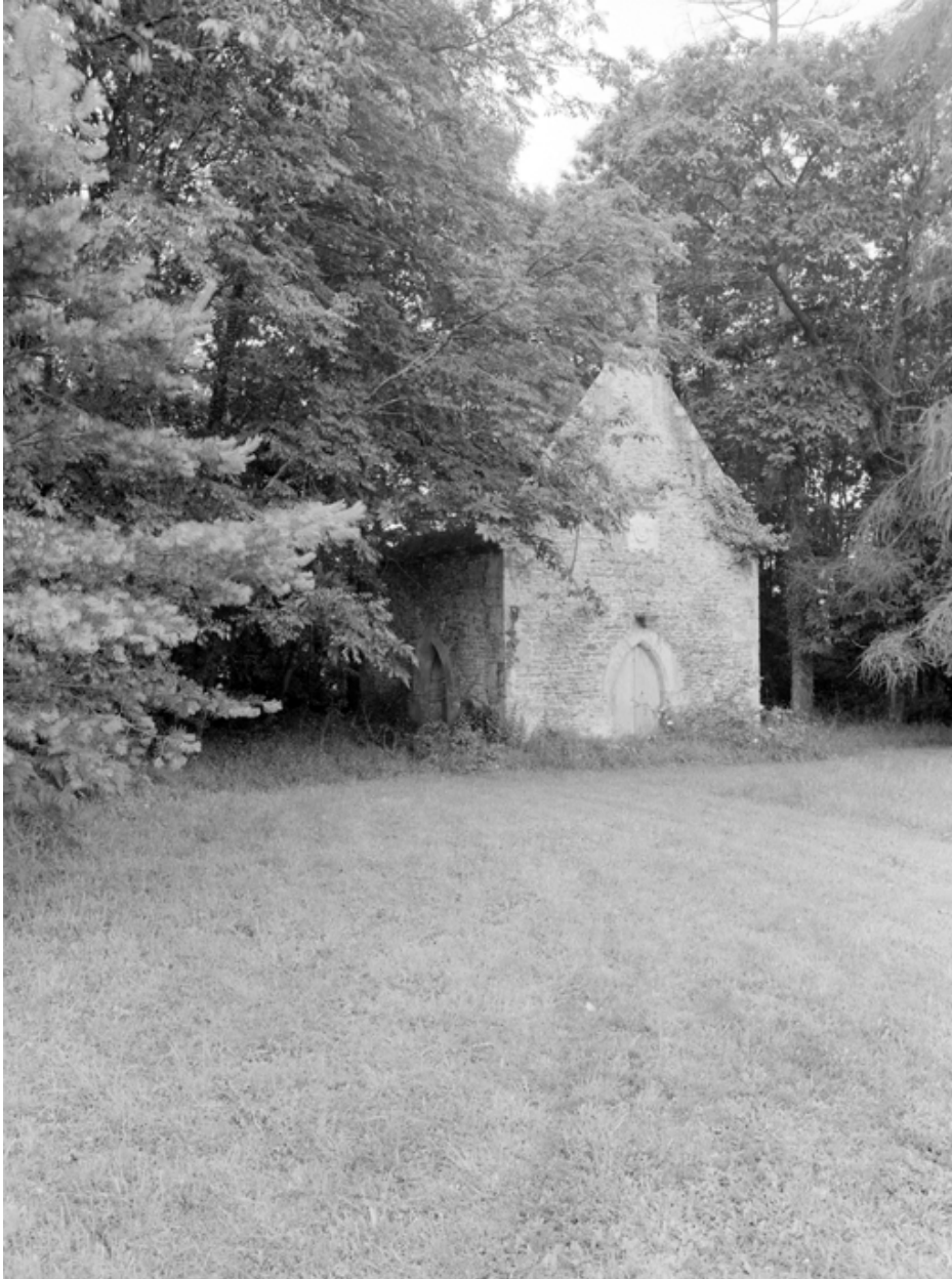
Chapelle : vue générale prise du nord.
