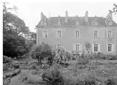
Élévation postérieure. Phot. Norbert Lambart IVR53_19805600622X
