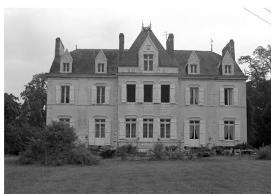
Élévation antérieure. Phot. Norbert Lambart IVR53_19805600621X
