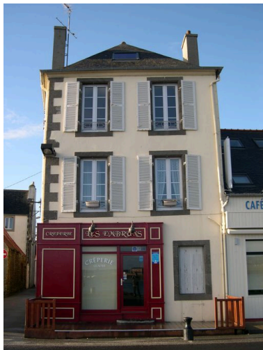
Elévation côté quai de l'ancien magasin de commerce pour l'avitaillement des navires
