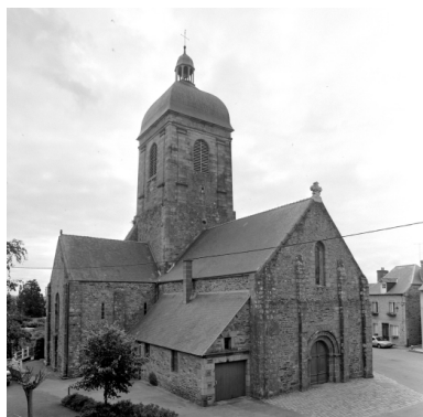
Élévation nord-ouest : vue générale Phot. Guy Artur, Phot. Norbert Lambart IVR53_19943501261X
