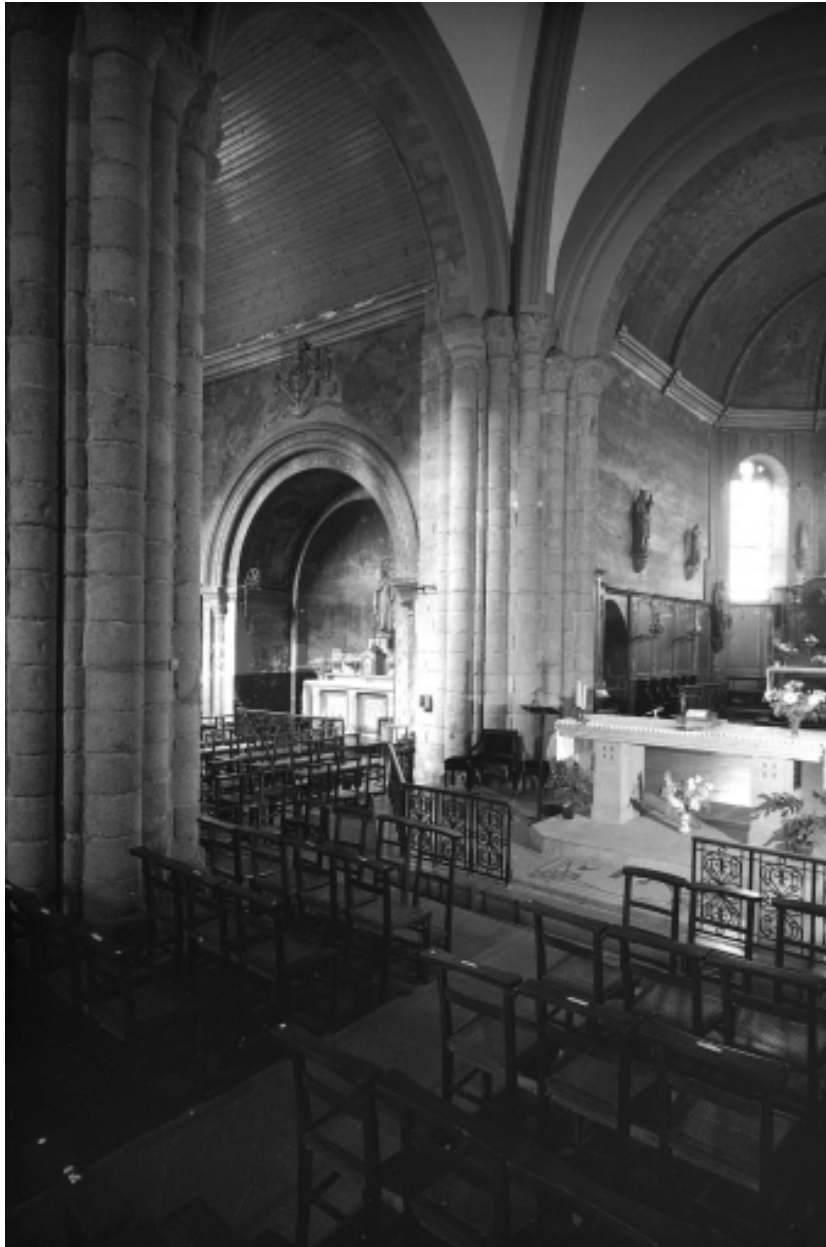
Croisée du transept, pilier nord-est : vue générale
