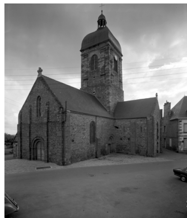
Élévation sud-ouest : vue générale Phot. Guy Artur, Phot. Norbert Lambart IVR53_19773500406V
