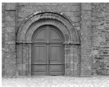
Elévation ouest : portail Phot. Guy Artur, Phot. Norbert Lambart IVR53_19943501262X
