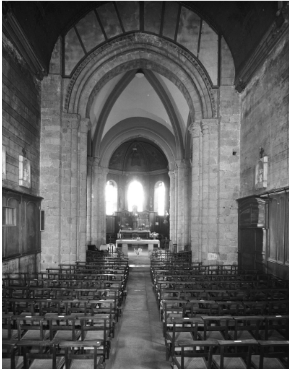
Vue générale vers le choeur
