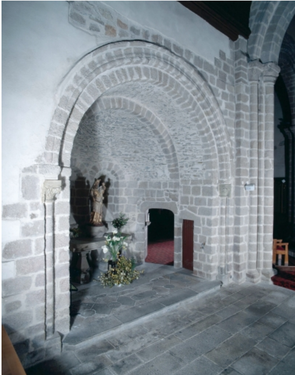
Chapelle nord : vue générale
