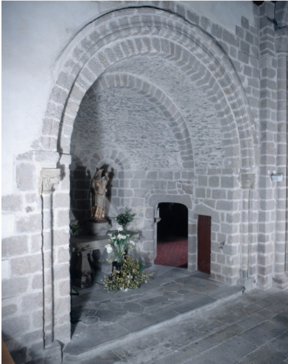
Chapelle nord : vue générale
