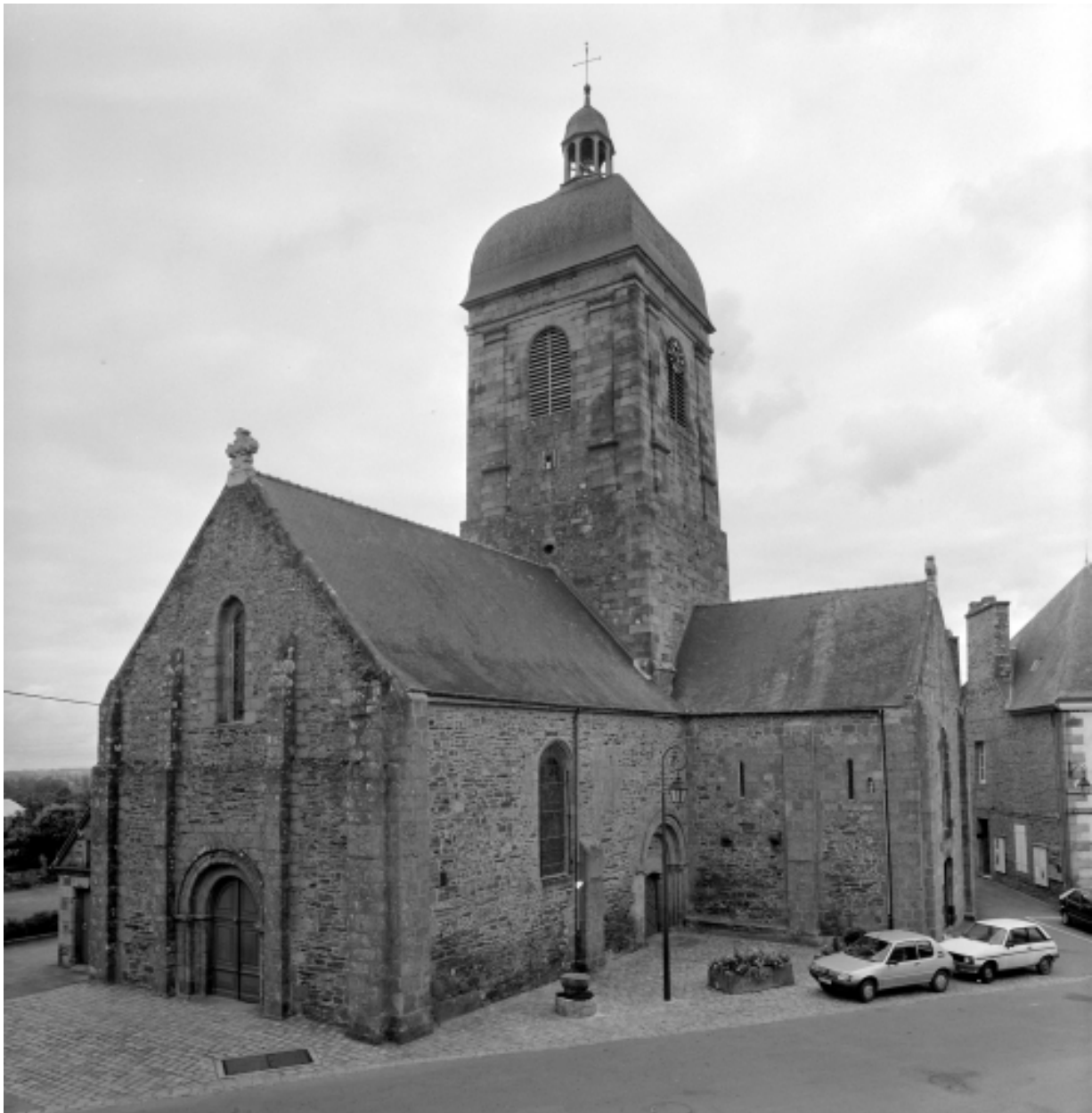
Elévation sud-ouest : vue générale
