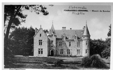
Vue générale Phot. Elise Lauranceau IVR53_20042905626NUCB
