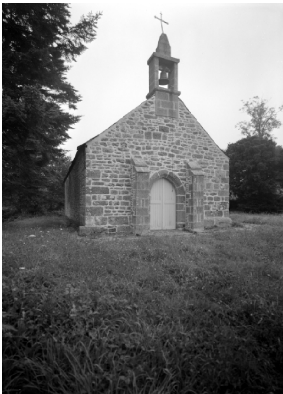
Vue de la façade occidentale
