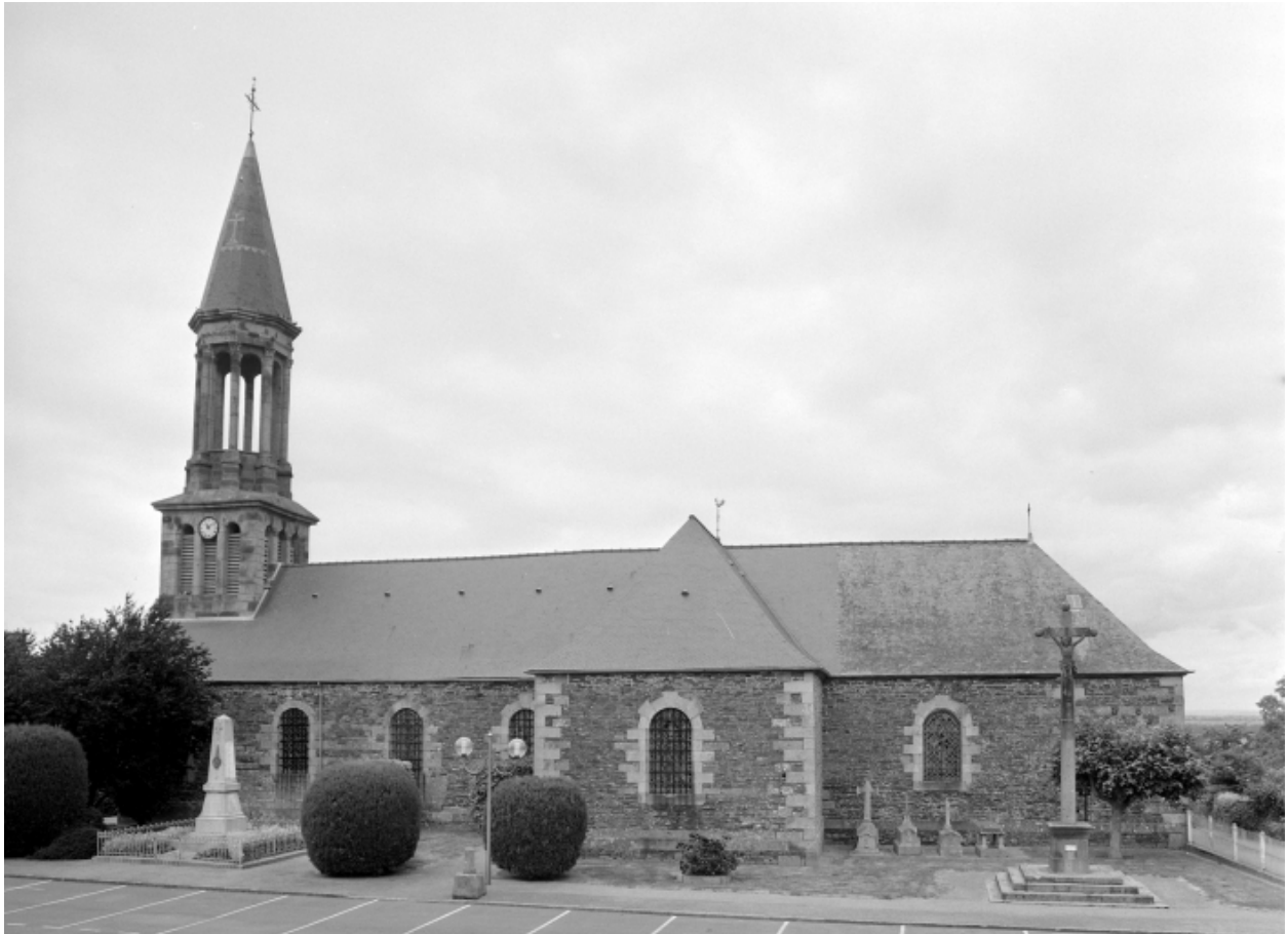
Elévation Sud : vue générale
