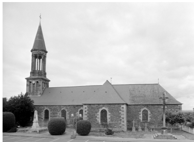
Elévation Sud : vue générale Phot. Guy Artur, Phot. Norbert Lambart IVR53_19943501266X
