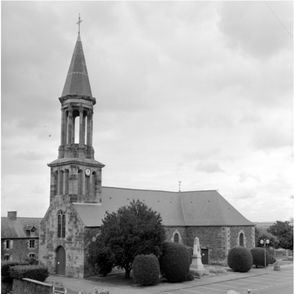
Elévation Sud-Ouest : vue générale
