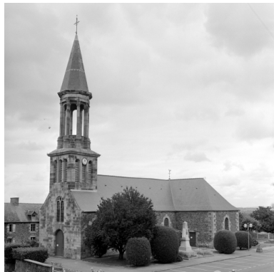
Elévation Sud-Ouest : vue générale Phot. Guy Artur, Phot. Norbert Lambart IVR53_19943501265X
