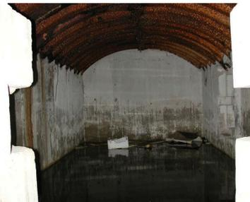
Vue de l'intérieur de l'abri type tôle métro (état en 2002). Le bunker est inondé
