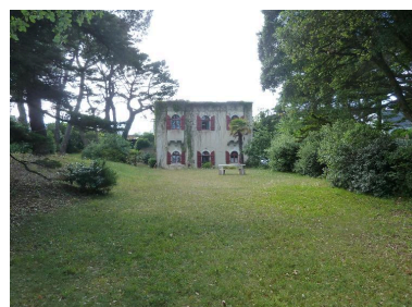
Saint-Pierre-Quiberon, batterie de Beg Quilvi, corps de garde crénelé. Phot. Patrick Jadé IVR53_20165606064NUCA
