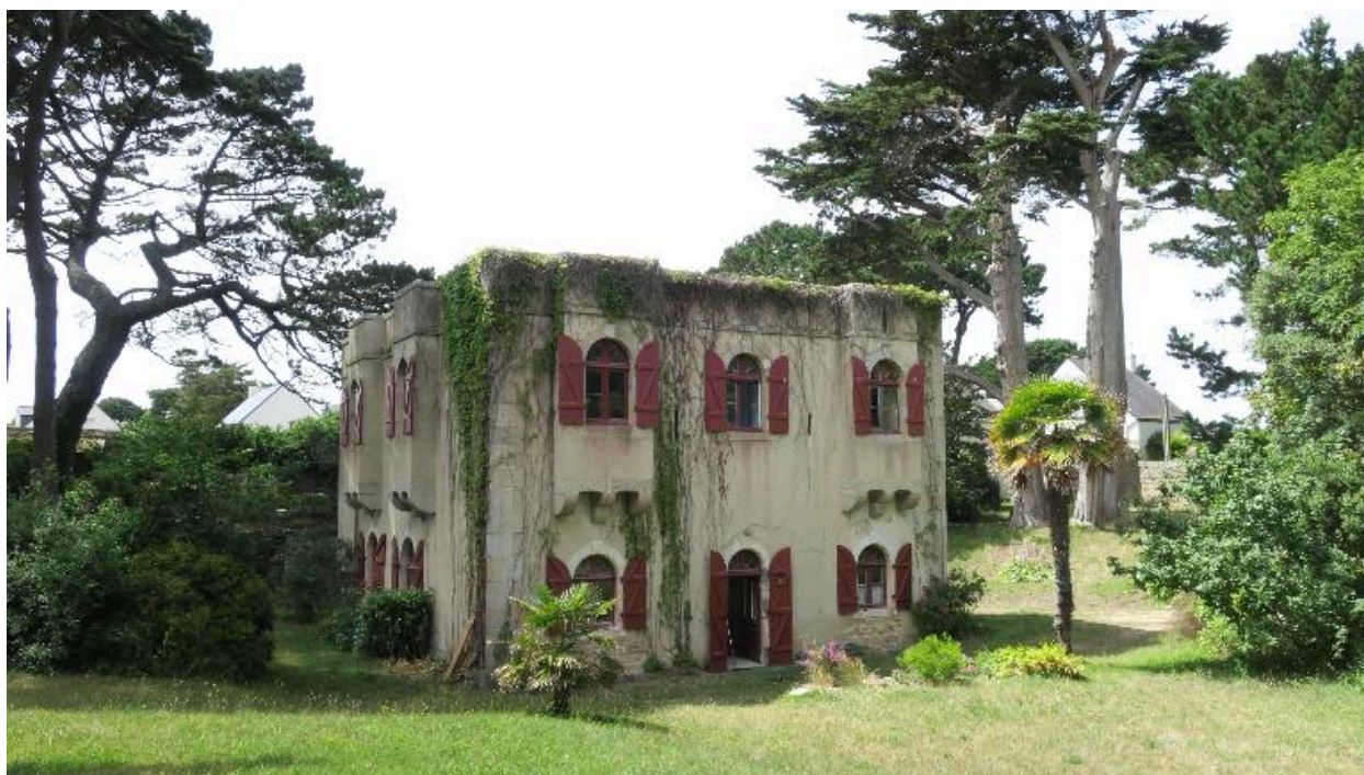
Saint-Pierre-Quiberon, batterie de Beg Quilvi, corps de garde crénelé.
