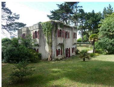
Saint-Pierre-Quiberon, batterie de Beg Quilvi, corps de garde crénelé. Phot. Patrick Jadé IVR53_20165606065NUCA
