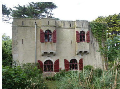
Saint-Pierre-Quiberon, batterie de Beg Quilvi, corps de garde crénelé, façade sud. Phot. Patrick Jadé IVR53_20165606066NUCA
