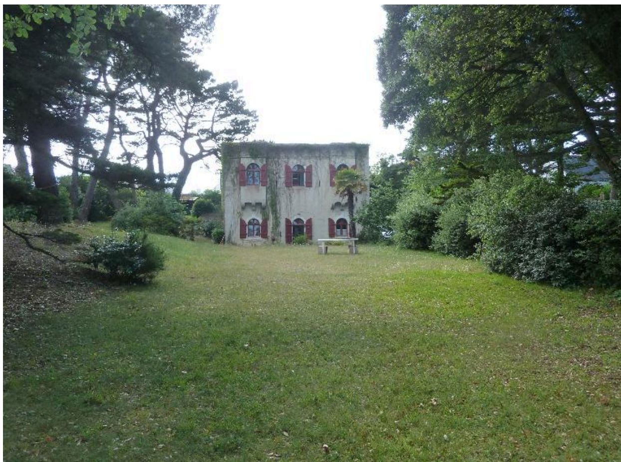
Saint-Pierre-Quiberon, batterie de Beg Quilvi, corps de garde crénelé.
