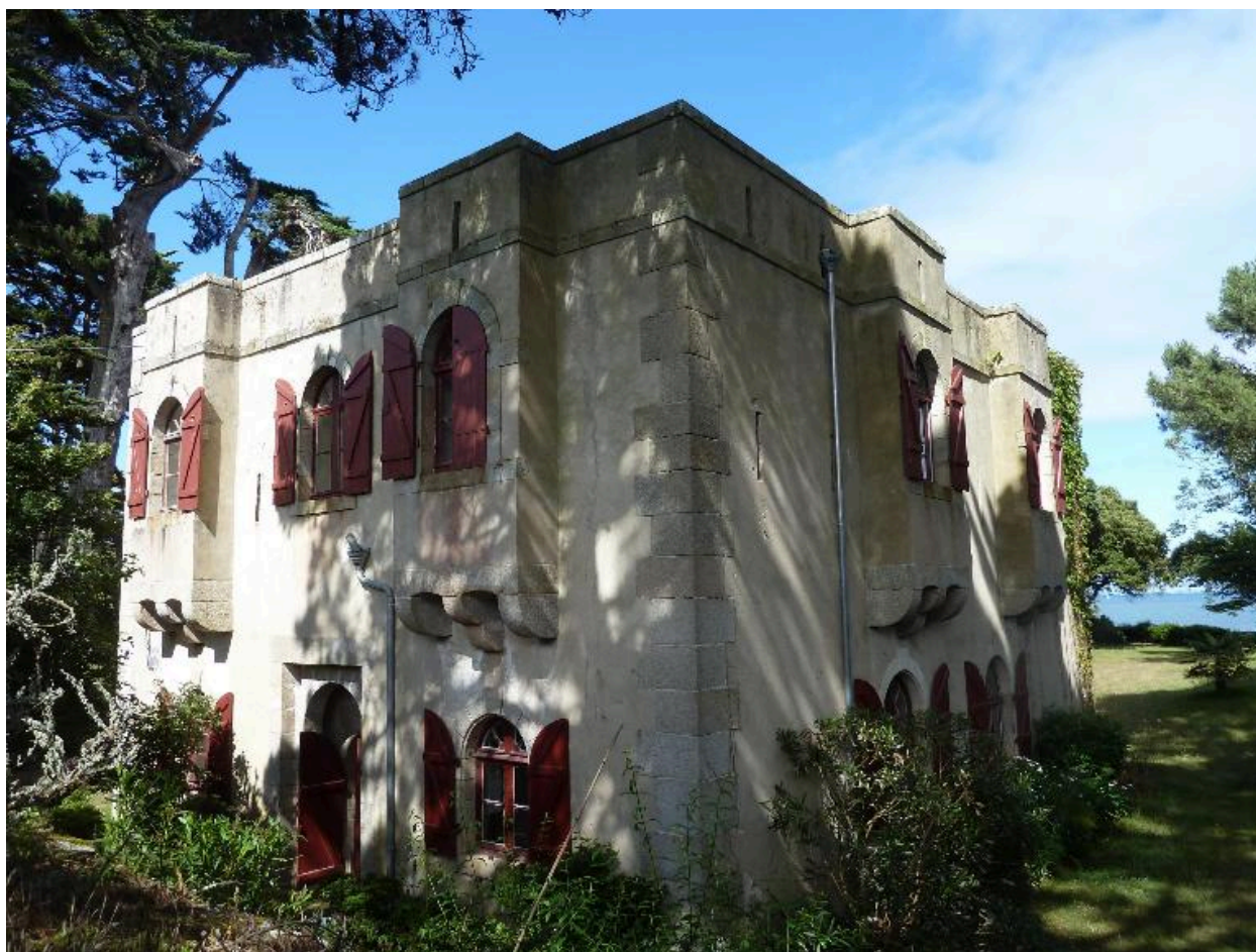
Saint-Pierre-Quiberon, batterie de Beg Quilvi, corps de garde crénelé, angle sud-ouest.
