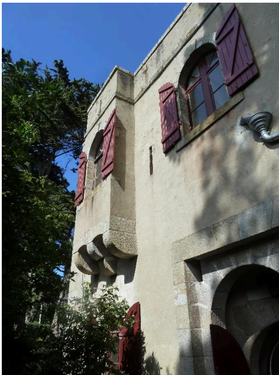
Saint-Pierre-Quiberon, batterie de Beg Quilvi, corps de garde crénelé, détail de la façade ouest.
