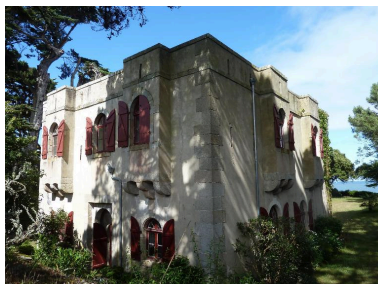
Saint-Pierre-Quiberon, batterie de Beg Quilvi, corps de garde crénelé, angle sud-ouest. Phot. Patrick Jadé IVR53_20165606067NUCA
