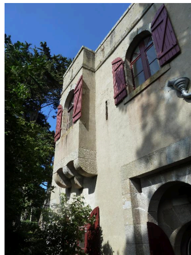
Saint-Pierre-Quiberon, batterie de Beg Quilvi, corps de garde crénelé, détail de la façade ouest. Phot. Patrick Jadé IVR53_20165606068NUCA
