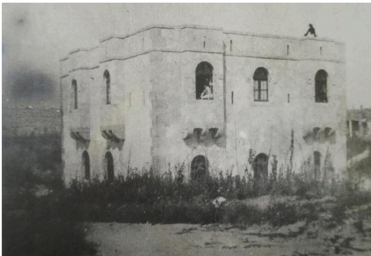
Saint-Pierre-Quiberon, batterie de Beg Quilvi, corps de garde crénelé après modification .
