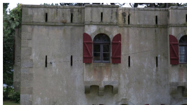
Saint-Pierre-Quiberon, batterie de Beg Quilvi, corps de garde crénelé, bretèches de la façade nord.
