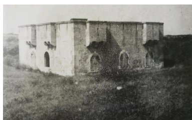
Saint-Pierre-Quiberon, batterie de Beg Quilvi, corps de garde crénelé avant modification. Phot. Lionel Duigou IVR53_20175608663NUCA
