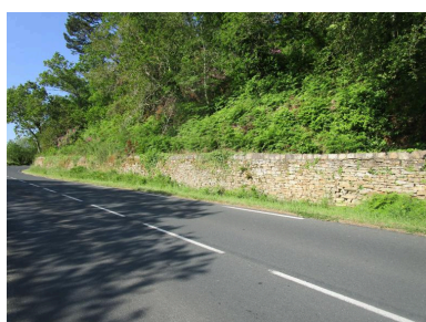
Mur d'enceinte au nord- est du domaine. (2023) Phot. Fabien Serre IVR53_20232905589NUCA
