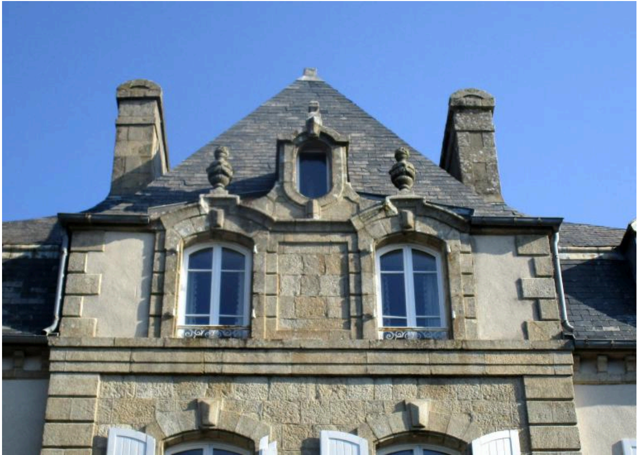
Élévation sud, corps central, détail des lucarnes. (2023)
