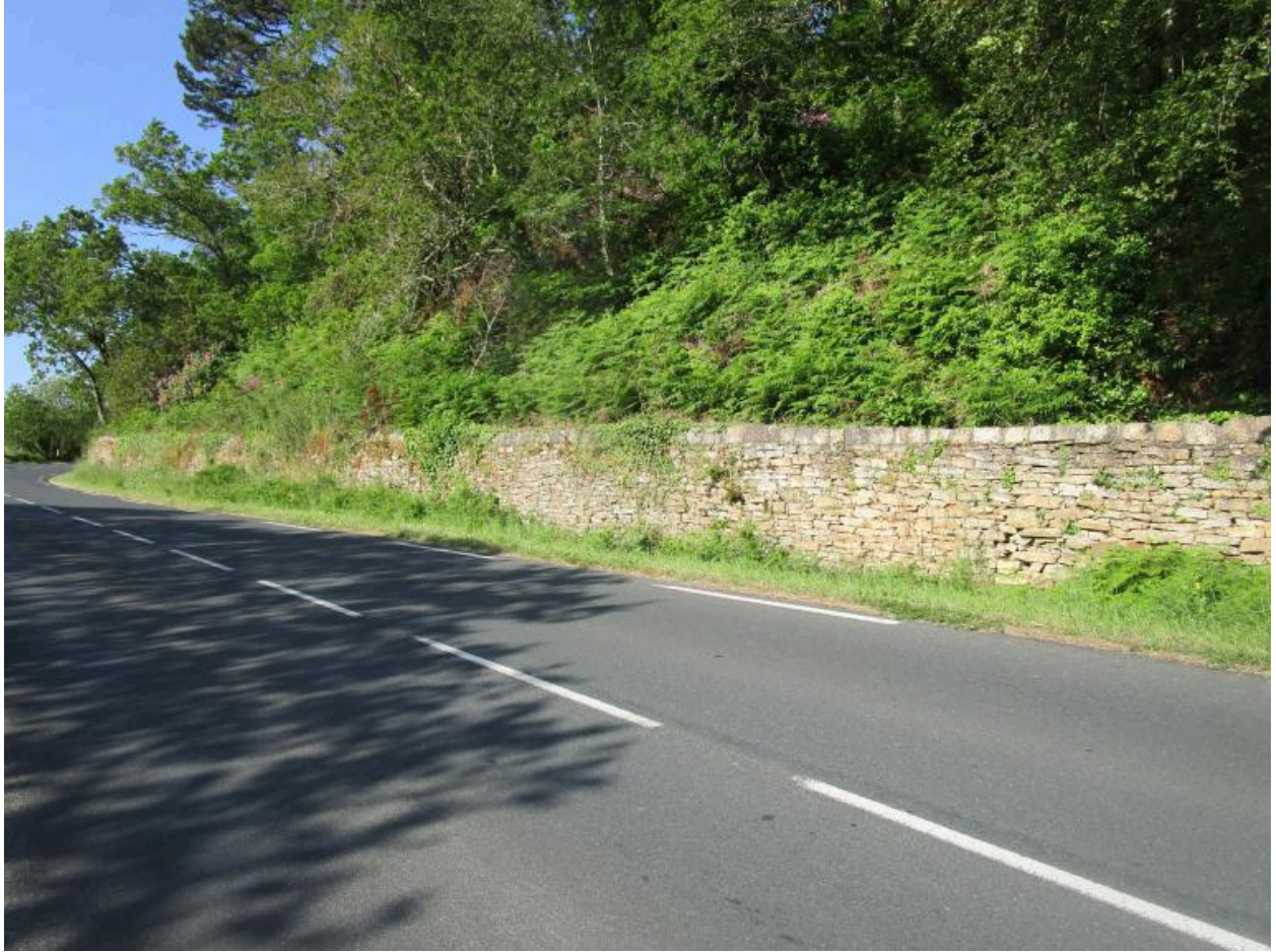
Mur d'enceinte au nord-est du domaine. (2023)
