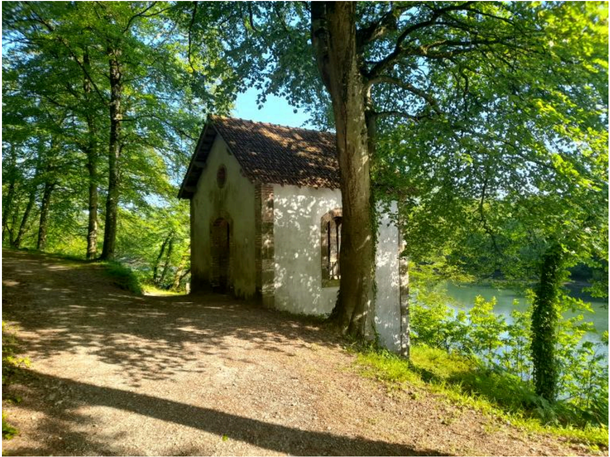
Pavillon d'agrément isolé dans le bois de Sugensou, vue générale prise du sud. (2023)
