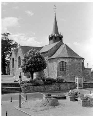
Elévation sud-est : vue générale Phot. Guy Artur, Phot. Norbert Lambart IVR53_19943500925X
