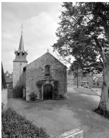
Elévation ouest : vue générale Phot. Guy Artur, Phot. Norbert Lambart IVR53_19943500926X
