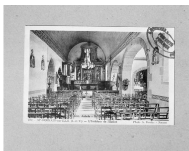
Intérieur : vue générale vers le chœur (Carte postale ancienne, AD35 : 6Fi) Repro. Guy Artur, Repro. Norbert Lambart, Autr. A. Donias IVR53_19933500889XB
