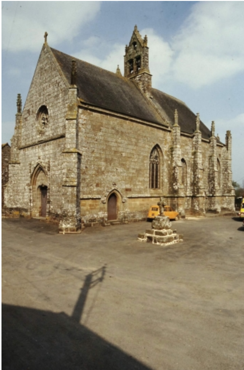
Vue générale prise du sud-ouest.
