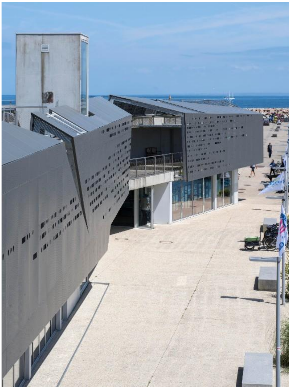
Espace commercial du port de plaisance de Roscoff
