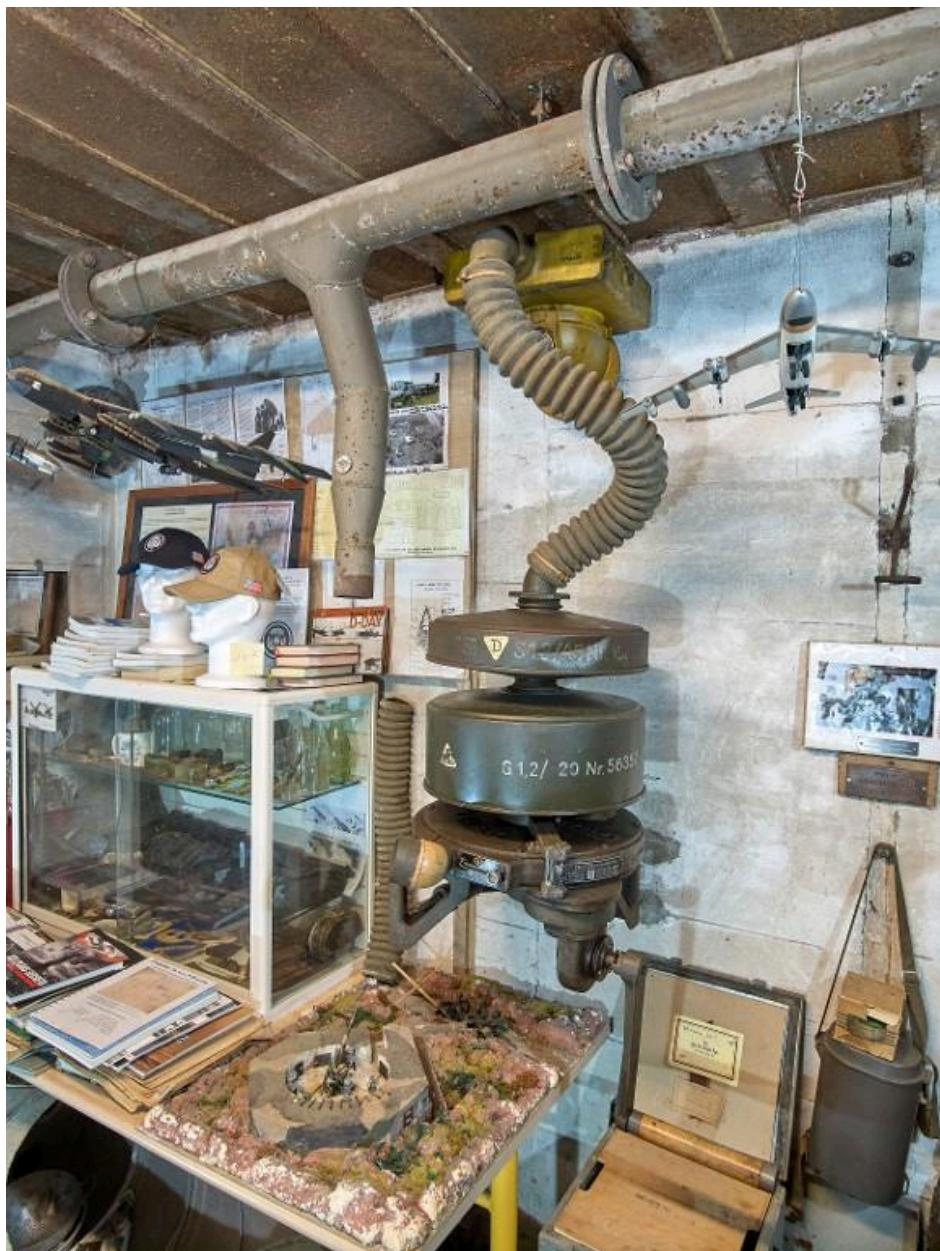
Vue intérieure : atelier, système de ventilation et de filtration avec ventilateur de 1,2 m<sup>3</sup>, filtre dépollueur et tuyauterie d'origine en place (les filtres sont rapportés). Ce bunker-musée a pour thématique la Seconde Guerre mondiale
