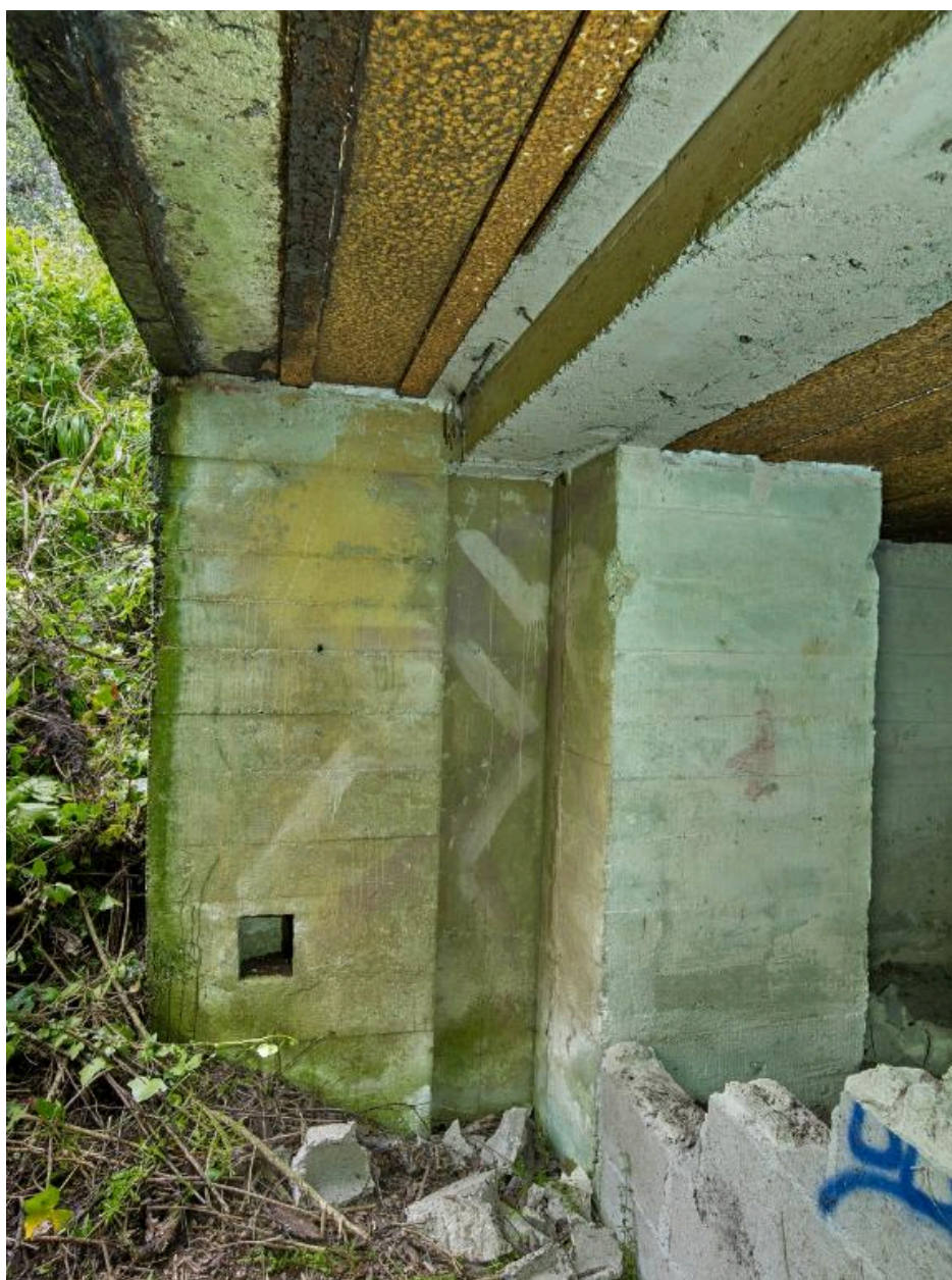
Vue de l'entrée (partiellement murée par des parpaings) : sur le mur Ouest, traces de peinture camouflage
