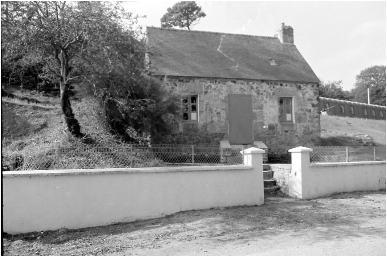
Vue des lignes de Quéléren en 1972 : corps de garde situé près de la porte de Crozon
