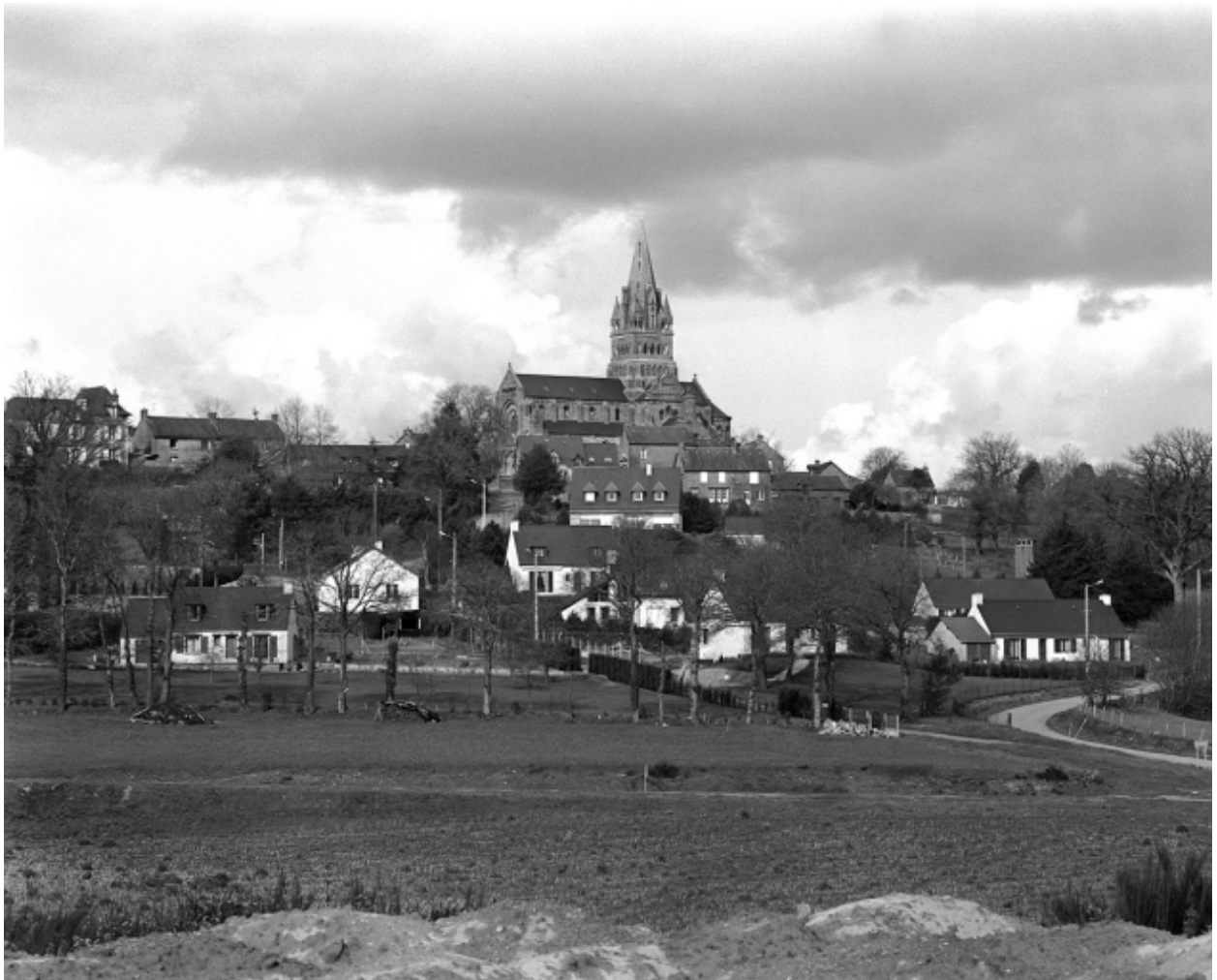
Elévation sud ; vue de situation
