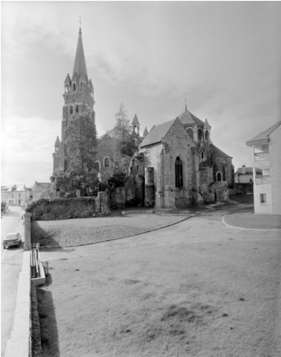
Elévation nord : vue générale
