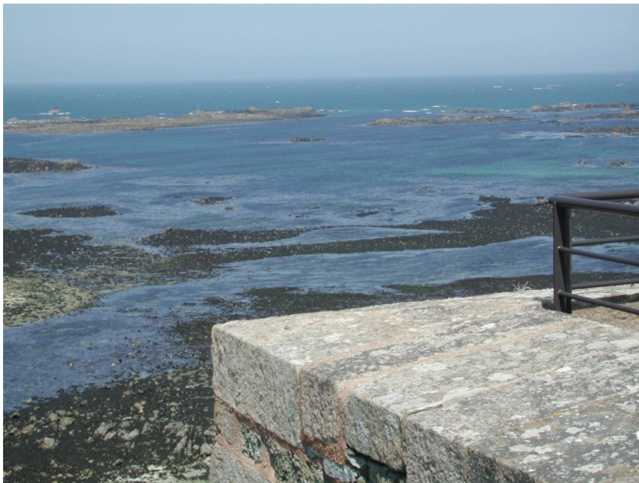
Le parapet du mur servant de garde corps du côté ouest de la terrasse
