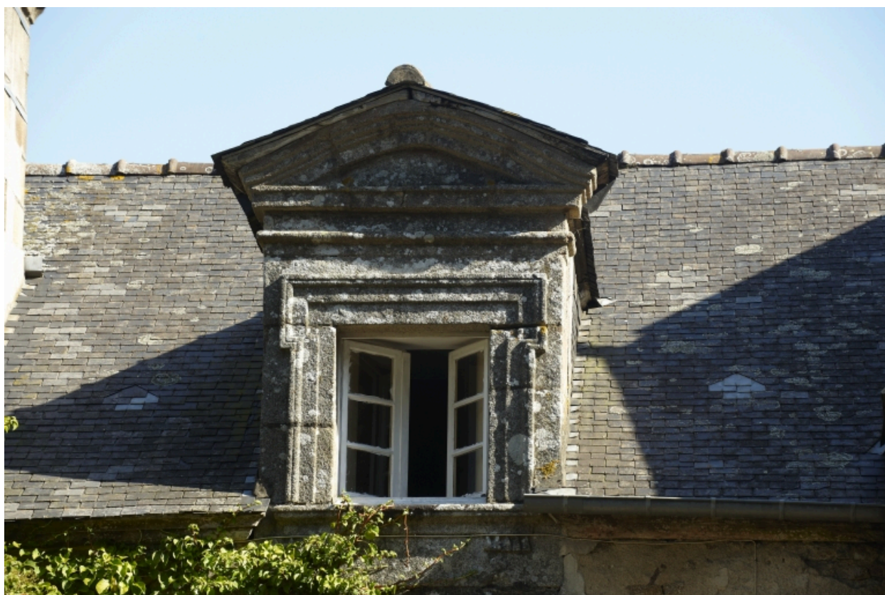
Détail de l'une des lucarnes des communs
